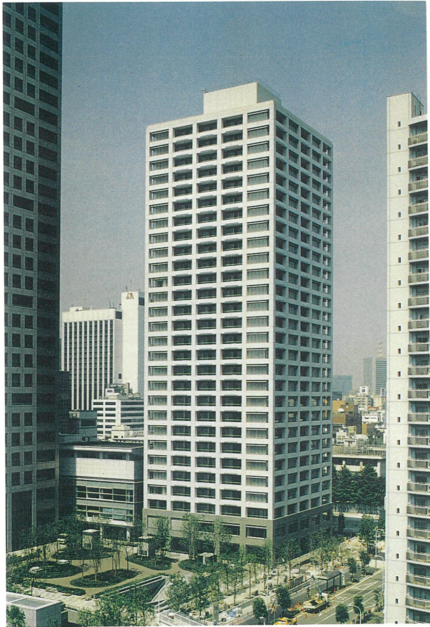
写真9.2.6 SHIP住宅（エヌ・ティ・ティ、都市開発、日総建、鹿島建設）
