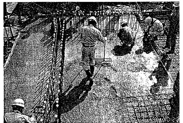
写真-8.2.9 仕上げ状況
