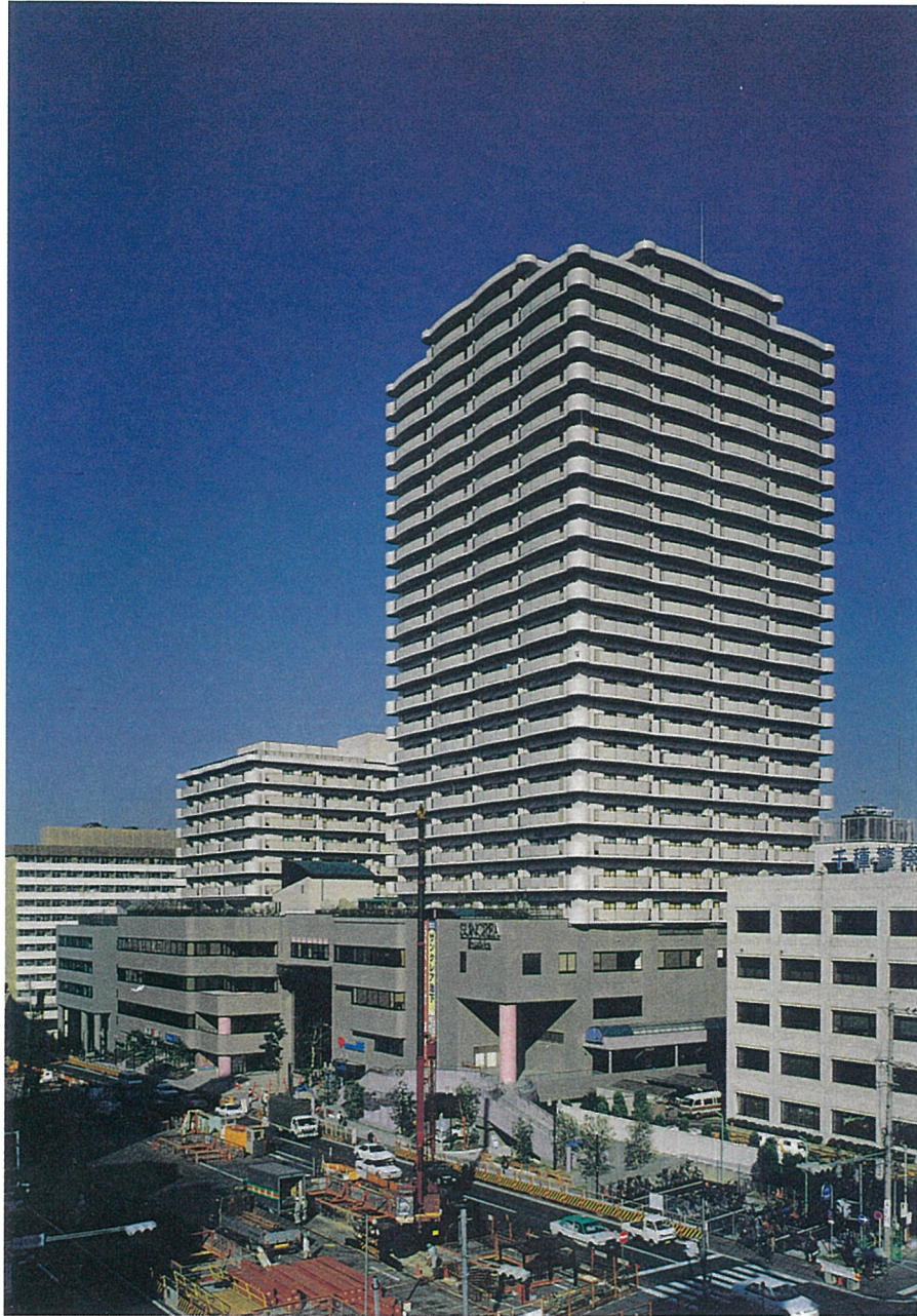
写真9.2.7 池下再開発ビルB棟（鴻池、日本国土、不動特定建設工事JV）
