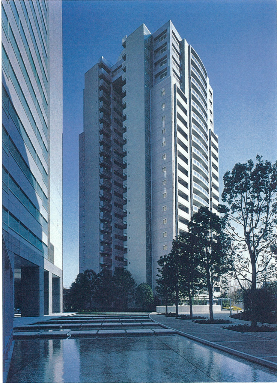
写真9.2.8 本駒込二丁目B棟（戸田建設）
