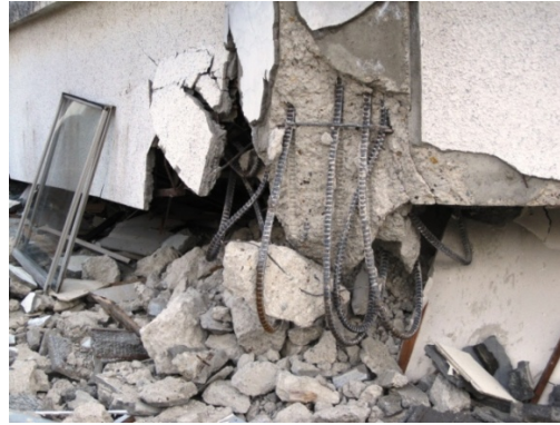
写真 38 隅柱の崩壊
