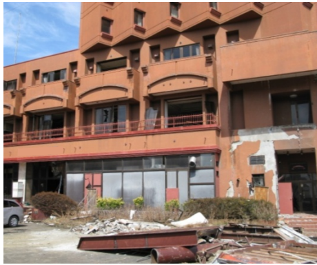
写真 15 RC 造（一部 SRC）の棟
