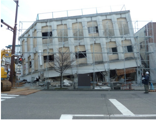
写真 37 1階の層崩壊
