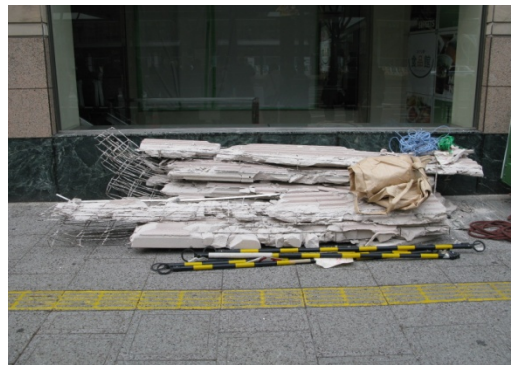
写真 68 落下した ALC パネル
