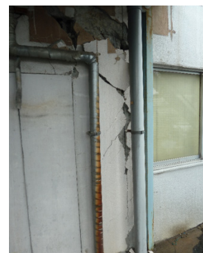
写真 112 曲げ破壊
