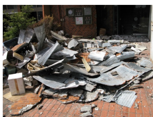
写真 21 落下した外壁の仕上げ
