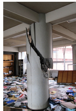
写真 115 3階柱の破壊
