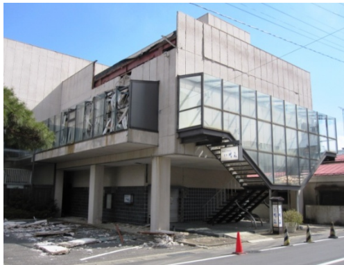
写真 59 帳壁の脱落 1
