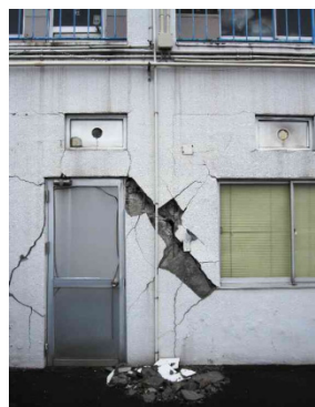
写真 111 せん断破壊
