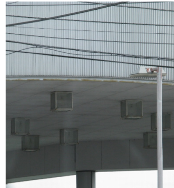
写真 136 無被害の類似天井
