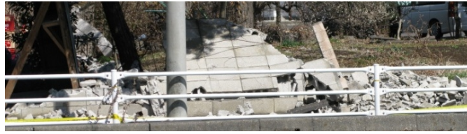
写真 24 ブロック塀の倒壊
