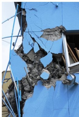
写真 114 2階柱の破壊
