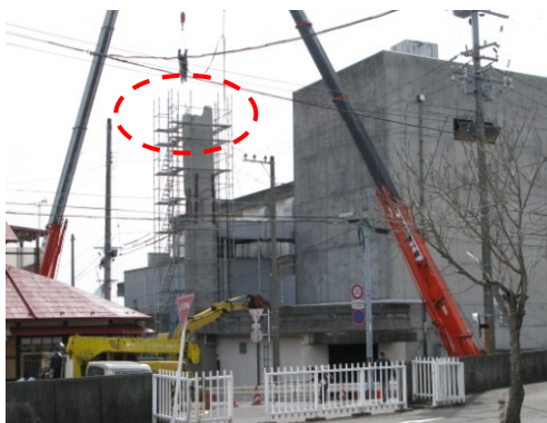
写真1 亀裂の入った煙突の上部を解体中
