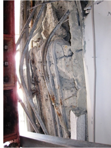
写真 47 柱段落とし部詳細
