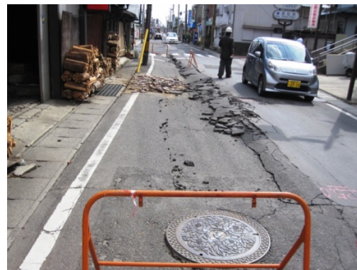
写真 62 道路の地盤変状
