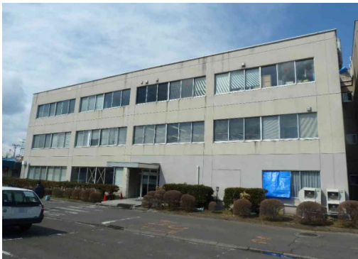
写真 120 建物外観 (写真右端で隣棟と接続)
