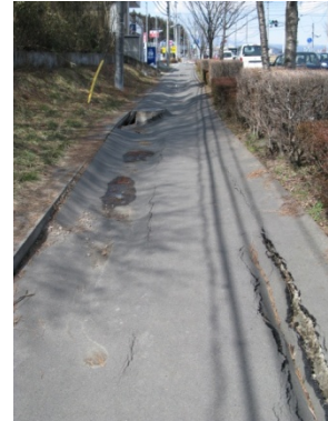
写真12 歩道の沈下
