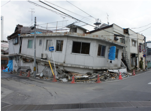
写真 57 建物概観外観
