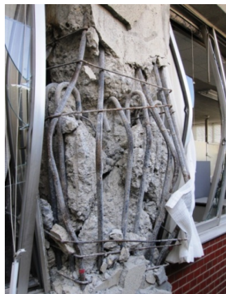
写真29 主筋段落とし部を
