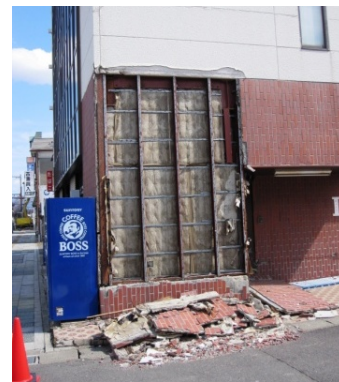
写真 60 帳壁の脱落 2
