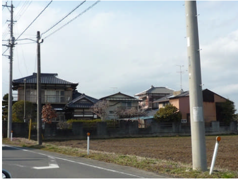
写真3 取手市紫水の屋根瓦の被害例
