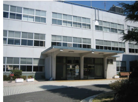
写真6 立ち入り禁止となった常総市役所庁舎
