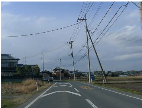
写真5 傾いた電柱（取手市浜田付近）
