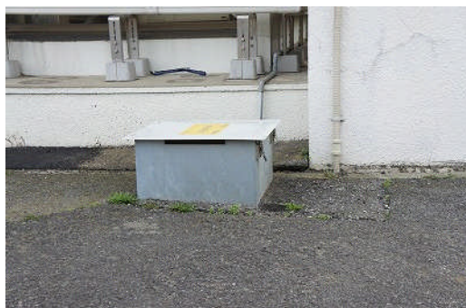
写真 1 龍ヶ崎市震度計設置状況
