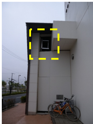
図 4.14-5 エキスパンションジョイント部の可動パネルの損傷（脱落）
