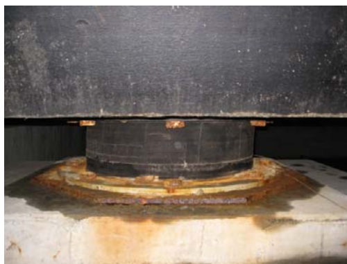
図 4.2-6 高減衰積層ゴムの状況
