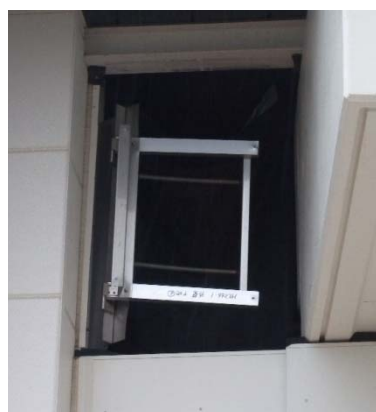
図 4.14-5 エキスパンションジョイント部の可動パネルの損傷（脱落）
