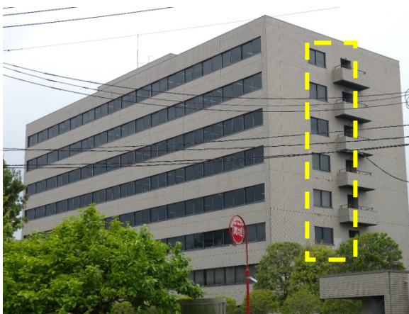
図 4.1-7 隣接する非免震建築物と外装材の被害（タイルの破損・落下）
