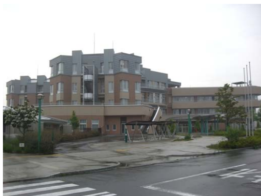
(a) 建築物外観 (2008 年調査 1)時)
