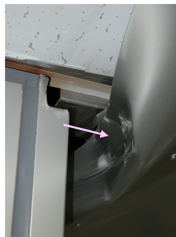
(e) B 1 階エレベータ入口天井部での衝突痕
