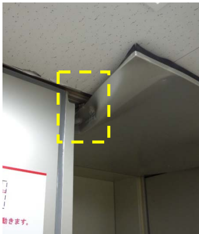
(e) B 1 階エレベータ入口天井部での衝突痕
