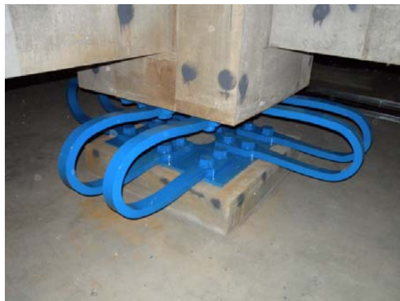
図 4.4-3 U型鋼材ダンパー
