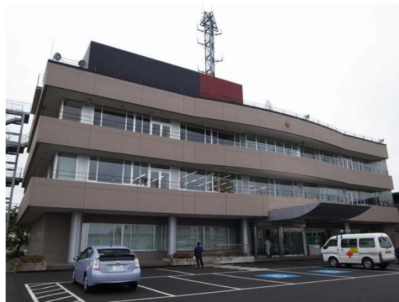
図 4.10-1 J 建築物 (鉄骨造 3 階)
