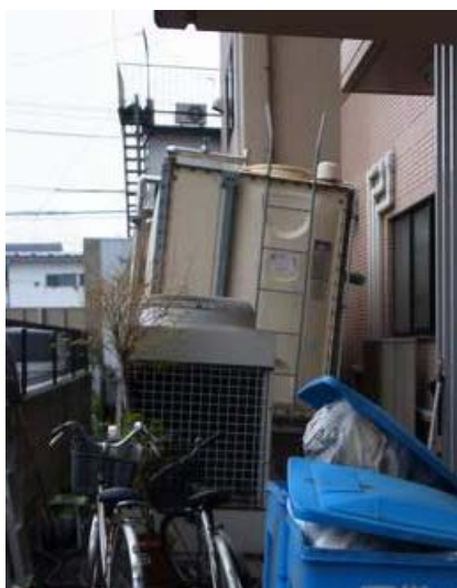
図 4.9-2 建築物周囲の貯水槽の傾斜
