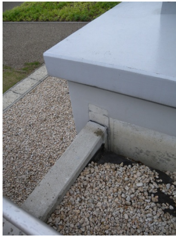
(a) 周囲構造物とのずれ
