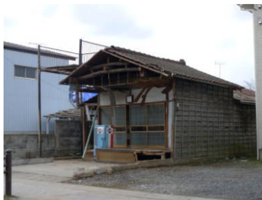
写真 5.2.11-2 損壊部が撤去された住宅 (水戸市本町)
