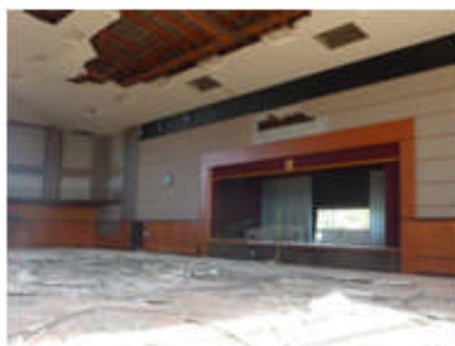
写真 5.4-207 天井の脱落2
