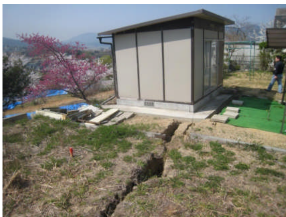
写真 5.5.2.3-29 緑ヶ丘1丁目の斜面地①および頂部に生じた地割れ（一部ブルーシート掛け）
