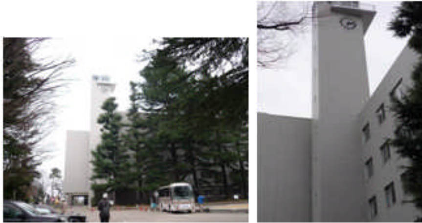
写真 5.4-69 県庁本庁舎及び時計塔の外観
