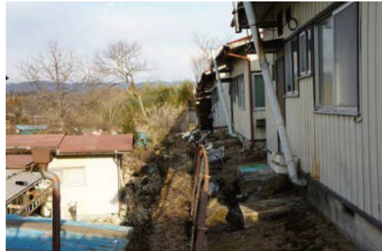
写真 5.2.7-20 写真 5.2.7-19 の立地 (擁壁上部)
