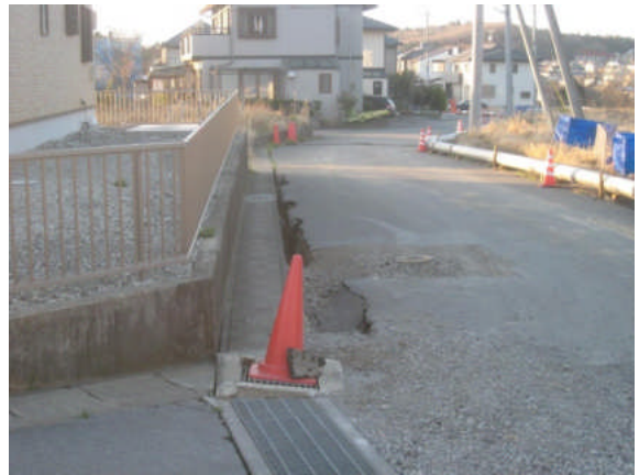
写真 5.5.2.3-56 地割れの痕跡
