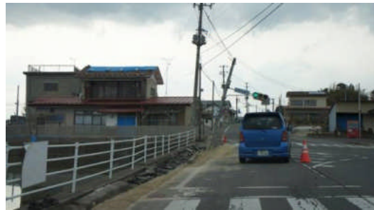
写真 5.2.6-26 傾倒した信号機
