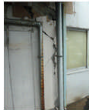
写真 5.4-49 曲げ破壊
