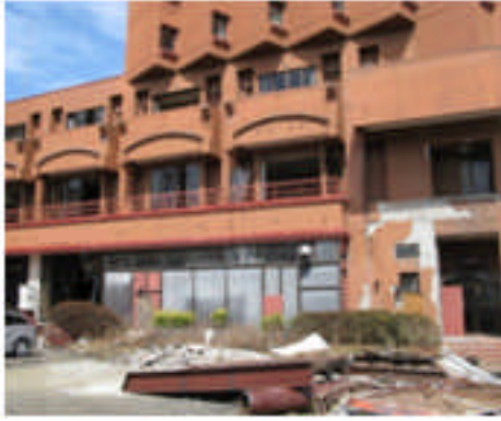
写真 5.4-169 RC造（一部SRC）の棟
