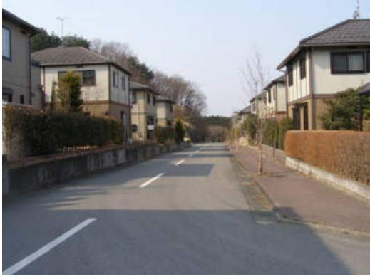
写真 5.2.8-3 ロビンシティ地区の 無被害住宅
