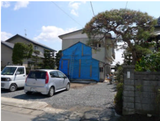
写真 5.2.2-22 前面部分が解体済みの木造
