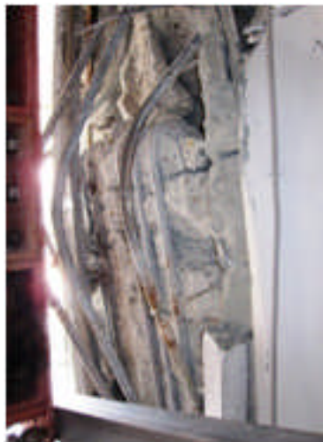
写真 5.4-141 柱段落とし部詳細
