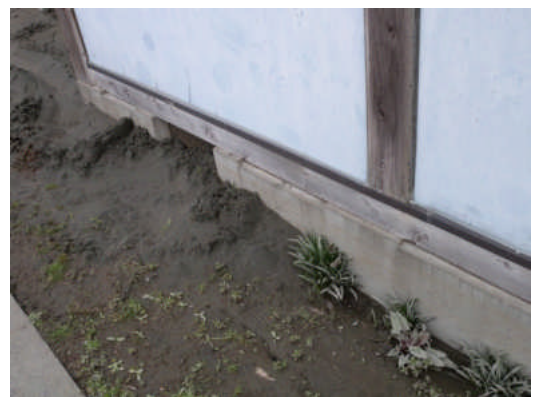
写真 5.5.2.1-32 基礎部分の外観（2）
