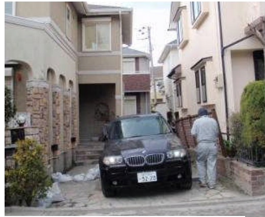
写真 5.5.2.2-10 傾斜した住宅
