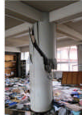
写真 5.4-52 3階柱の破壊
