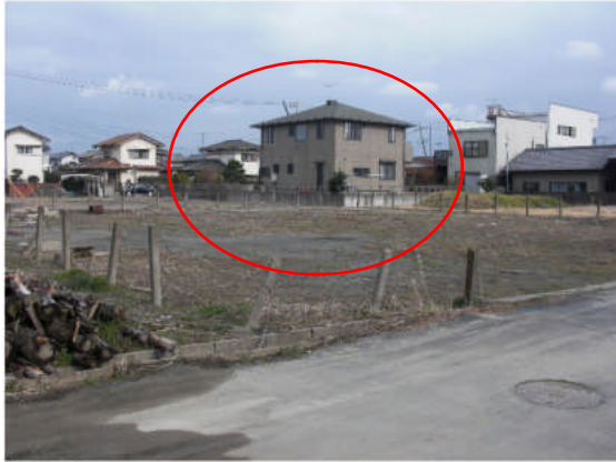
写真 5.5.2.1-33 液状化の発生していない住宅
