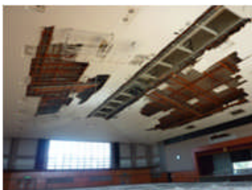
写真 5.4-206 天井の脱落1
