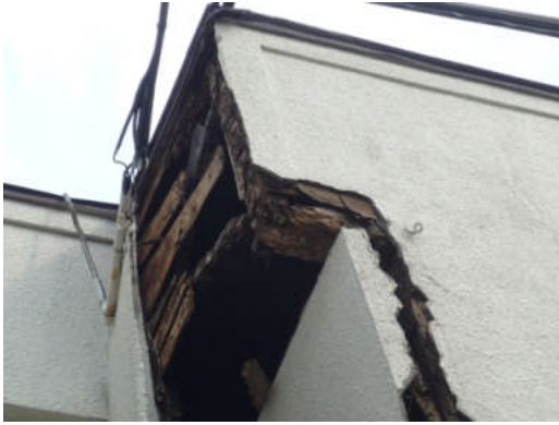
写真 5.2.6-9 写真 5.2.6-8 で外壁モルタル
