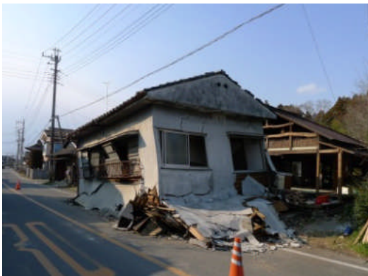
写真 5.2.10-5 倒壊した住宅 (那珂市瓜連)
