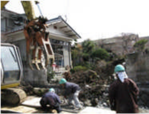
写真 5.4-159 被災したブロック塀（解体中）
