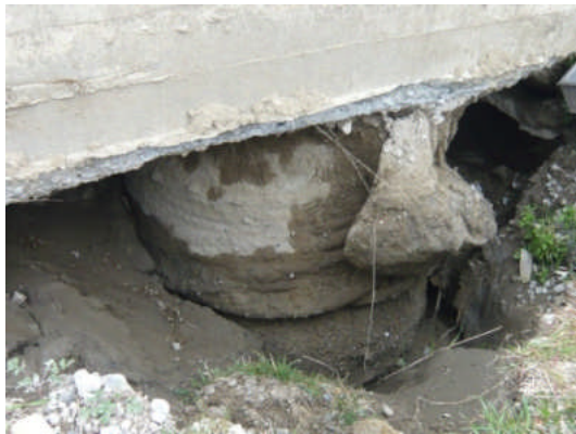
写真 5.5.2.1-22 杭頭部の露出状況
