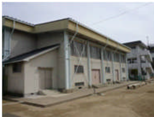
写真 5.4-85 屋内運動場外観
