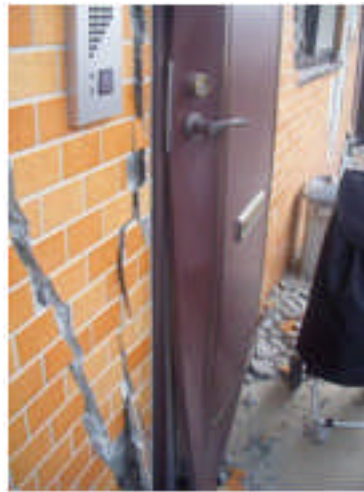
写真 5.4-98 玄関ドアの変形
