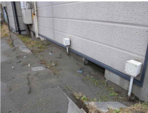
写真 5.5.2.1-31 基礎部分の外観（1）
