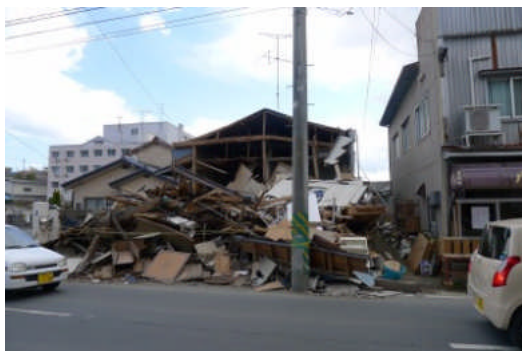
写真 5.2.4-3 倒壊した木造住宅
