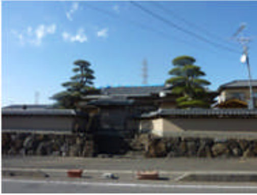
写真 5.4-210 木造住宅の瓦の被害
