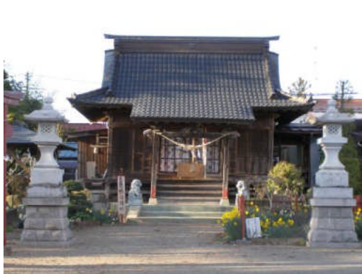
写真 5.2.3-9 残留変形が認められる神社
