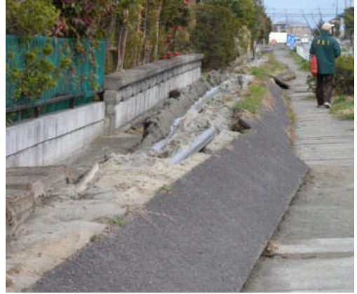
写真 5.5.2.1-27 歩道部分の沈下に伴う塀の被害 写真 5.5.2.1-28 歩道脇の埋設配管の浮き上がり
