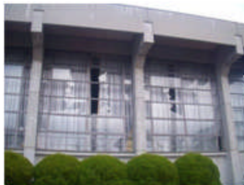
写真 5.4-100 大体育館のガラス破損状況 写真 5.4-101 小体育館のガラス破損状況
