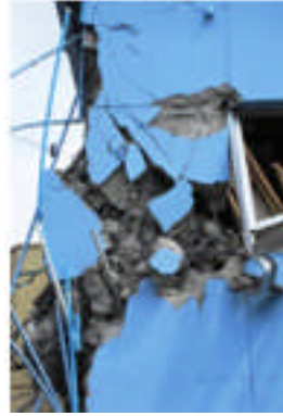
写真 5.4-51 2階柱の破壊
