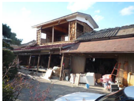
写真 5.2.3-8 1階が大きな残留変形の 住宅
