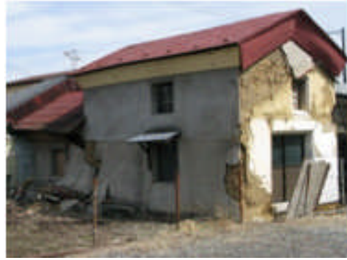
写真 5.4-158 土蔵の被害
