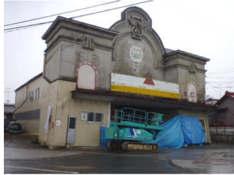
写真 5.2.1-10 古い映画館を改装した工場
