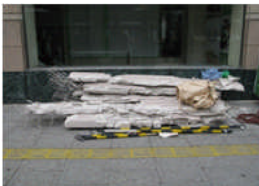
写真 5.4-6 落下したALCパネル
