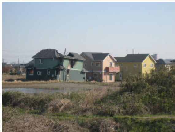
写真 5.5.2.1-49 液状化により傾斜した戸建て住宅群（手前の1棟は火災による被害か）
