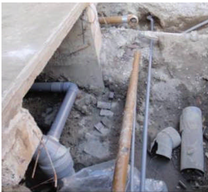
写真 5.5.2.2-17 設備配管の修復状況
