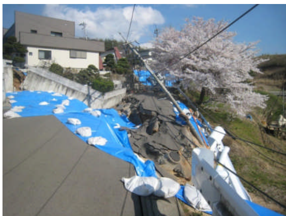
写真 5.5.2.3-45 丘陵の南西側の斜面地①の地すべりとそれによる住宅の被害
