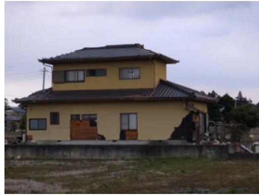
写真 5.2.9-4 モルタル外壁の剥落
