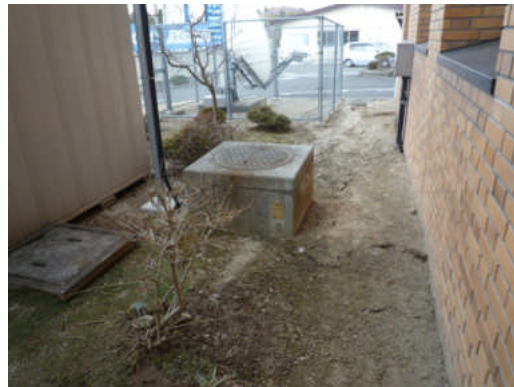
写真 5.2.6-28 震度計設置状況
