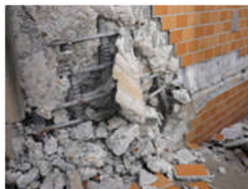
写真 5.4-95 1階柱脚部の破壊状況
