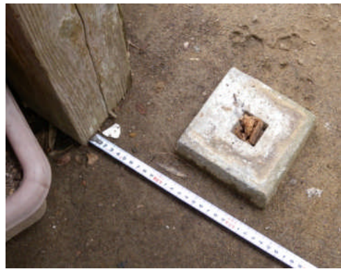
写真 5.5.2.1-10 物置柱脚の移動
