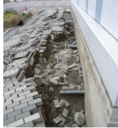
写真 5.5.2.1-21 建築物周囲地盤の状況
