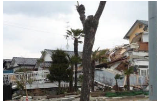
写真 5.2.6-22 倒壊家屋 (構造種別不明)
