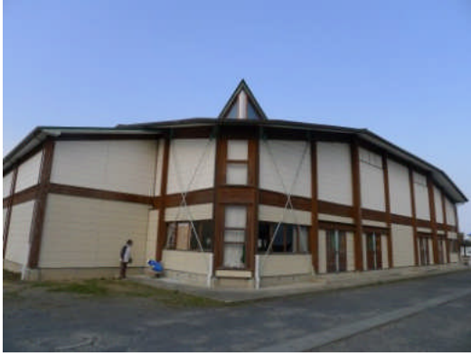
写真 5.2.10-7 集成材構造の木造体育館
