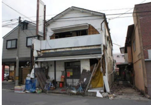
写真 5.2.6-4 大きく損壊した店舗併用住宅
