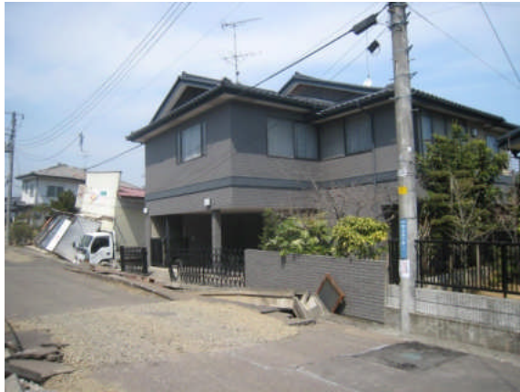
写真 5.5.2.3-3 宅地盛土の滑動・地盤変状による住宅の移動・沈下・傾斜
