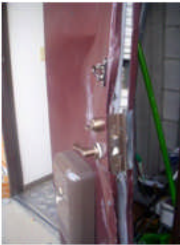
写真 5.4-98 玄関ドアの変形
