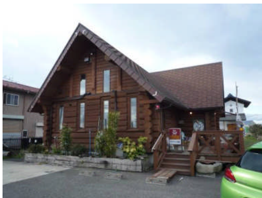
写真 5.2.3-7 外観無被害のログハウス 店舗
