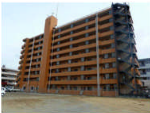
写真 5.4-93 集合住宅Bの外観
