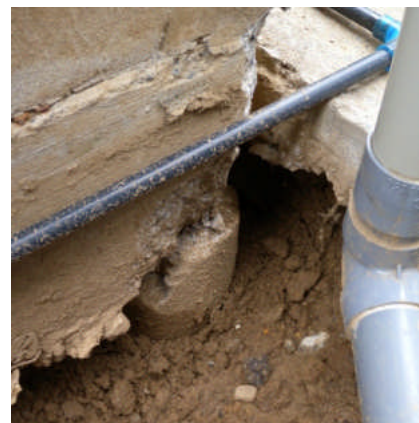
写真 5.5.2.1-12 建物角部の支持構造物
