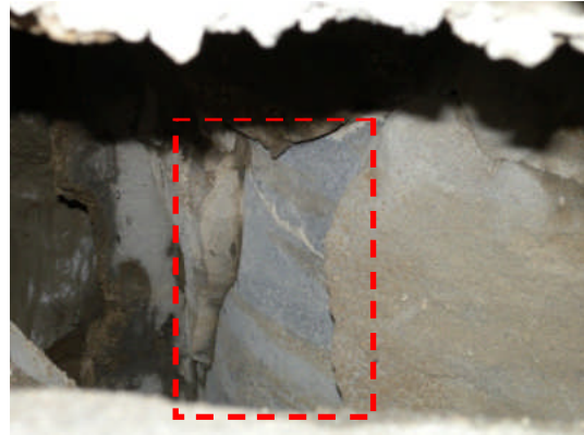
写真 5.5.2.1-23 杭周固定液の内部
