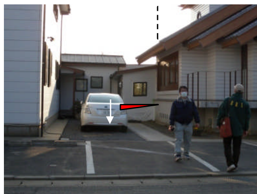
写真 5.5.2.1-36 接続部分の損傷及び駐車場
