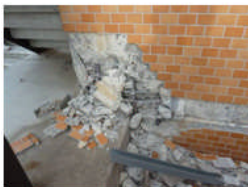
写真 5.4-95 1階柱脚部の破壊状況
