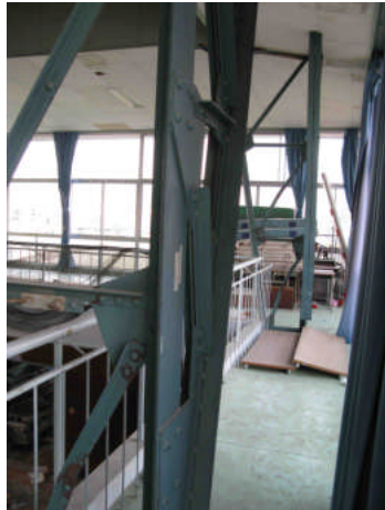
(a) ラチス柱全景
