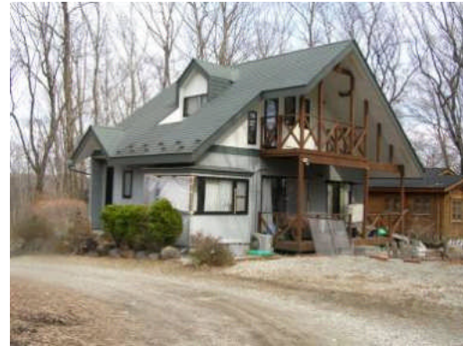
写真 5.2.7-12 窓ガラスの割れ (豊原乙地区)
