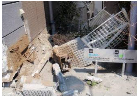
建物間の状況
