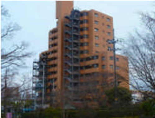
写真 5.4-102 集合住宅Cの外観
