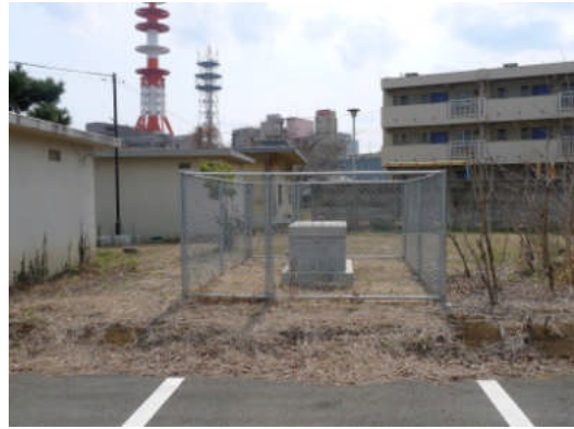
写真 5.2.11-4 JMA 水戸市金町震度計設置 状況
