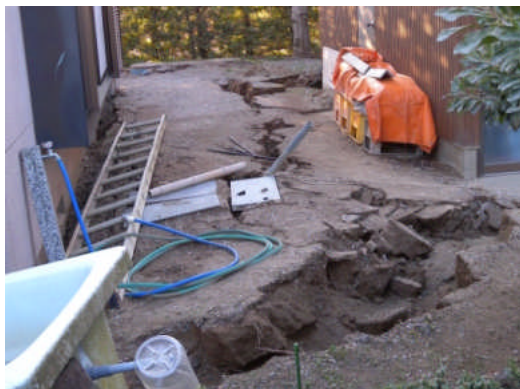
写真 5.5.2.1-37 敷地内の地割れ
