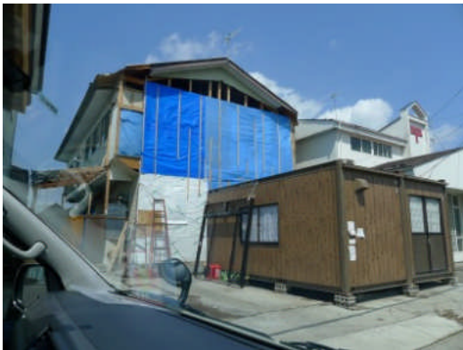
写真 5.2.2-20 前面部分が解体済みの木造
