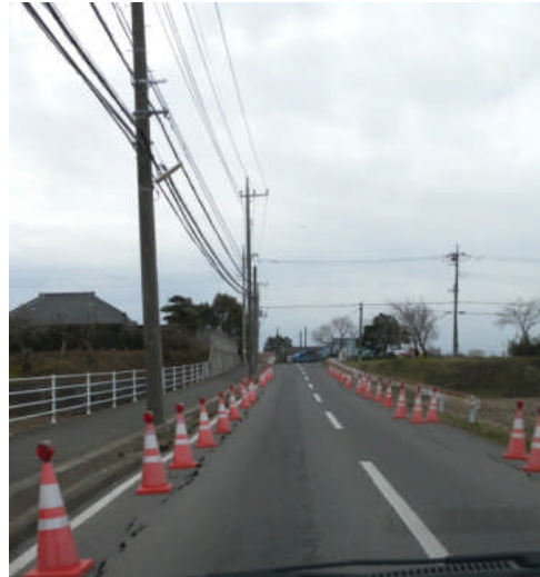
写真 5.5.2.1-2 路盤の亀裂
