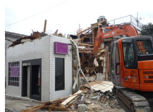
写真 5.2.6-14 写真 5.2.6-13 の解体撤去作業
