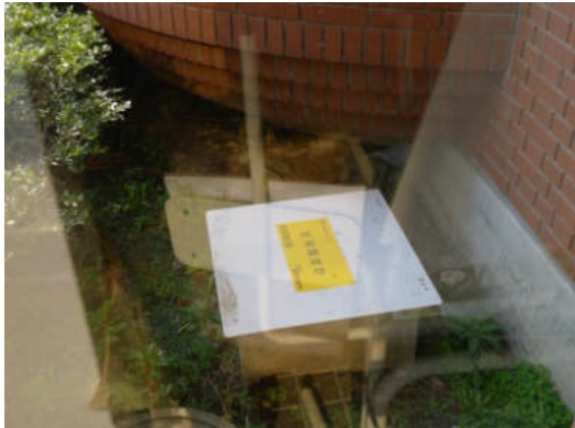
写真5.2.10-12 震度計設置状況(瓜連支所)
