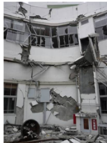
写真 5.4-77 本館中央部 (エキスパンション・ジョイントの 存在は確認できない)
