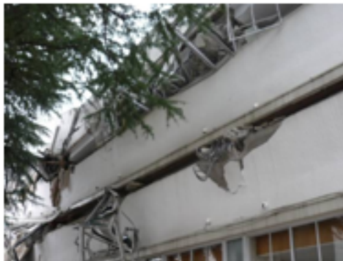
写真 5.4-78 2階層崩壊部
