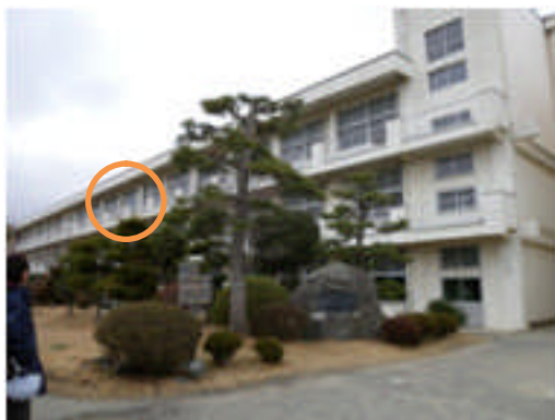
写真 5.4-178 A 中学校の校舎外観
