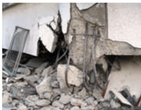
写真 5.4-132 隅柱の崩壊
