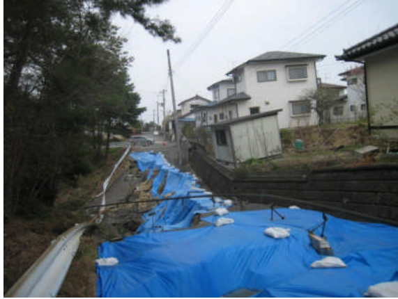
写真 5.5.2.3-39 高台の端部斜面①の地すべりによる盛土擁壁の破壊と住宅の傾斜
