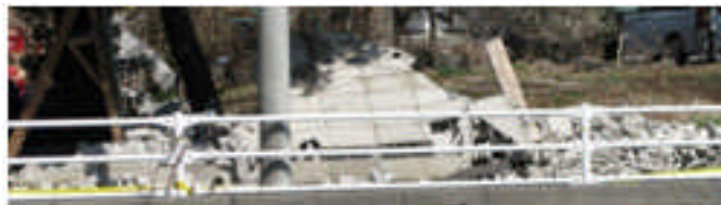
写真 5.4-176 ブロック塀の倒壊
