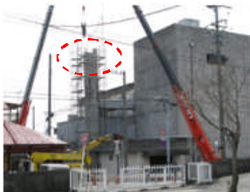
写真 5.4-155 亀裂の入った煙突の上部を解体中
