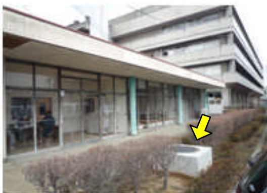
写真 5.4-118 震度計の設置状況
