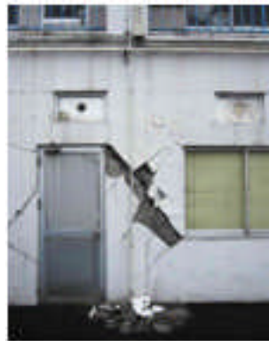
写真 5.4-48 せん断破壊
