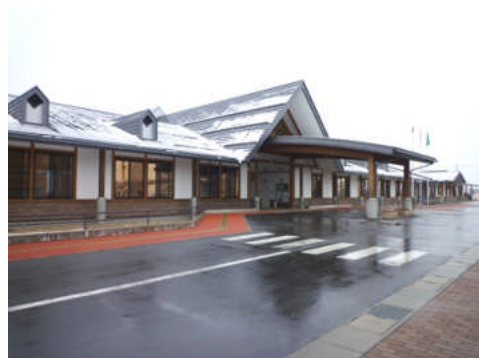
写真 5.2.1-20 木造で無被害の栗駒支所
