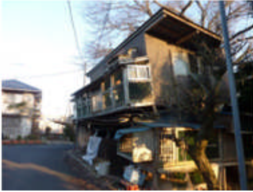
写真 5. 4-197 木造住宅の被害
