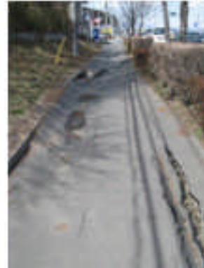
写真 5.4-166 歩道の沈下
