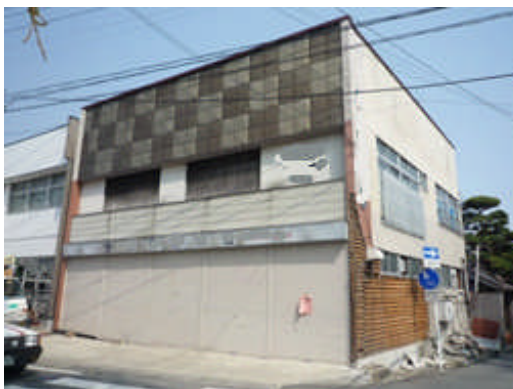
写真 5.2.2-4 残留変形がある店舗併用住宅
