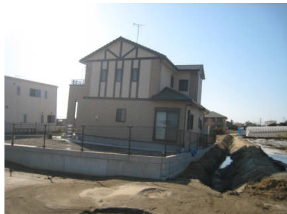
写真 5.5.2.1-44 写真 5.5.2.1-43 の戸建て住宅を反対側より臨む
