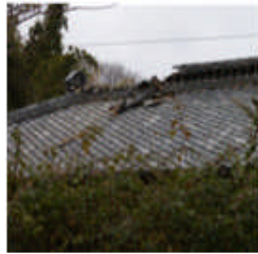
写真 5.4-185 拡大図(写真 5.4-181 の○印内)
