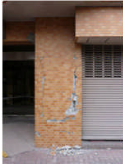
写真 5.4-96 1階柱のせん断ひび割れ 写真 5.4-97 1階柱の付着割裂ひび割れ
