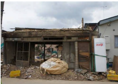
写真 5.2.6-23 解体撤去作業中の被災建築物
