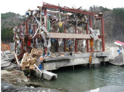
写真 6. 4. 2-20 残存する S 造（釜石市両石） （洗掘を受けて基礎杭まで見える。）
