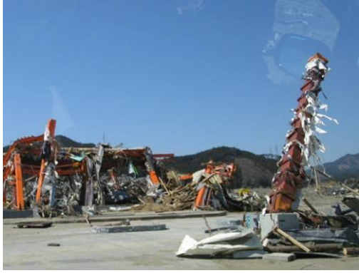
写真 6. 4. 2-3 根巻柱脚の1階柱の残存（陸前高田市）
