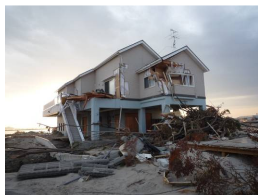
写真 6. 4. 3-7 1階RCピロティー構造の事例
