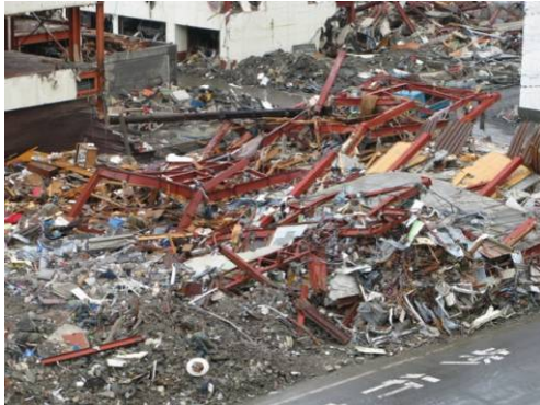
写真 6. 4. 2-7 1階及び2階柱の残存（女川町）
