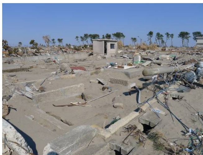
写真 6.4.3-2 上部構造と土台も流失した例
