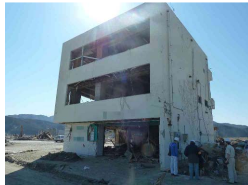
写真 6.4.1-2 残存する3階建て建築物
