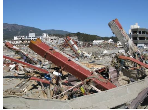
写真 6. 4. 2-4 1階柱の残存（陸前高田市）
