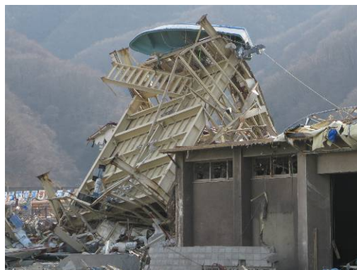
写真 6.4.2-2 柱脚部アンカーボルトの破断により移動したと考えられる建築物 (釜石市)
