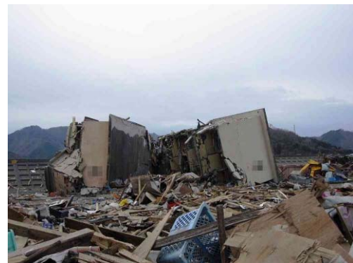
写真 6.4.1-8 集合住宅の転倒(CB造)
