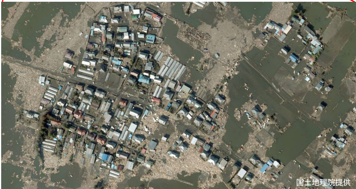
写真6.4.3-3 最大浸水深が低いいため、残存している事例（仙台市若林区荒浜地区）
