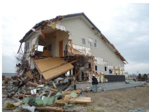
写真 6. 4. 3-6 建築物隅部を流失しつつも残存する事例 (2)
