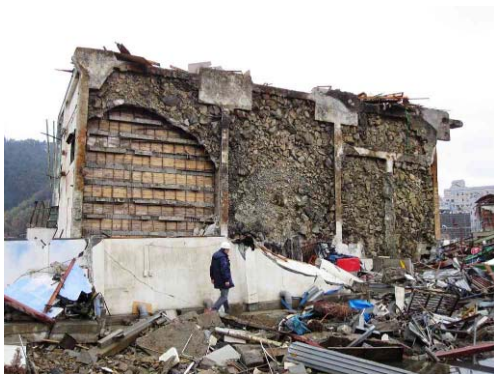
写真 6.4.1-7 塀を乗り越えた2階建て建築物
