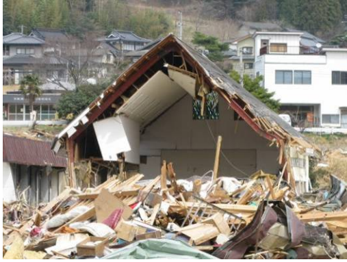
写真 6. 4. 2-13 傾斜した山形ラーメン架構 (大船渡～釜石間)
