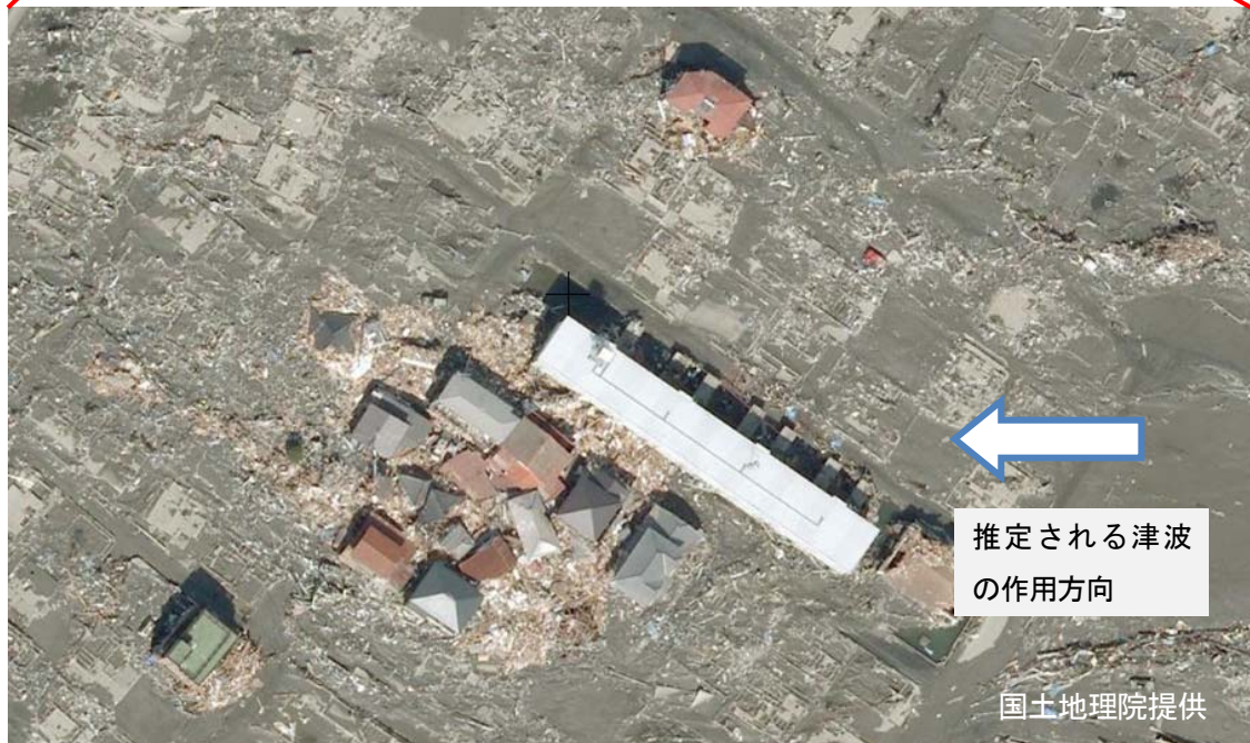
写真 6.4.3-4 津波の作用方向の前面に建つ建築物により津波波力が軽減し、残存したと考えられる例(名取市関上地区)
