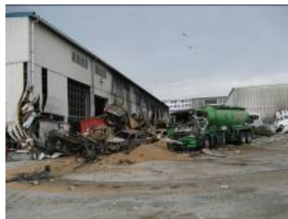
写真 7.3.1-1 仙台塩釜港北側の駐車場1の火災
