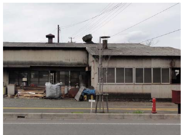
写真 7.3.24 奥州市水沢区羽田町の火災
