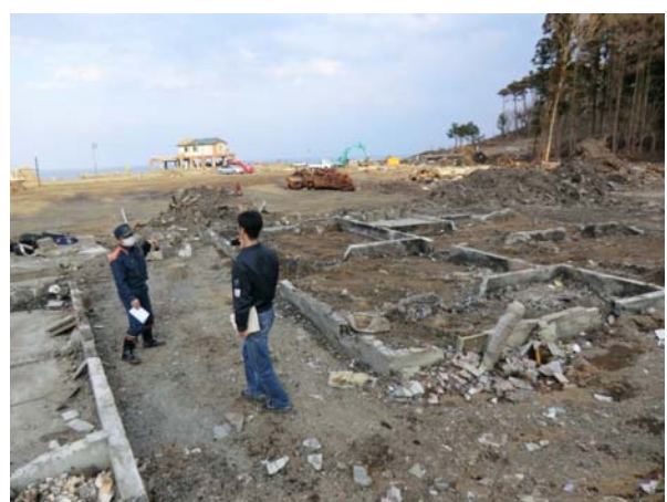
写真 7.3.8-1 火災現場付近
