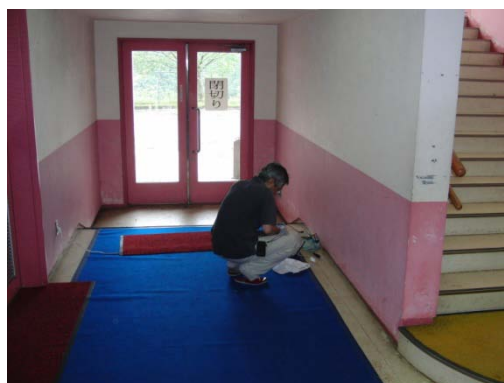
写真 4. 3-3 体育館 1 階床への設置状況
