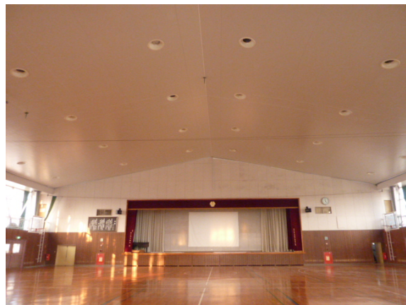
写真 5.3-19 耐震補強した体育館の内観
