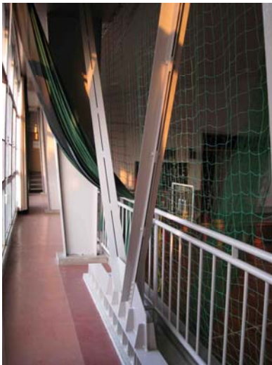
写真 5.3-18 増設した V 型の補強ブレース
