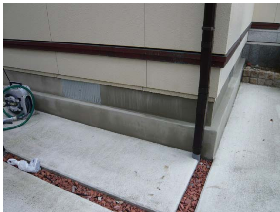
写真 5.5.1-35 基礎立上り部のブロック：修理済み
