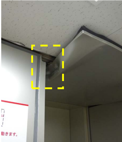
写真 5.5.1-4 B 1 階 E V 入口天井部での衝突痕 写真 5.5.1-5 免震スリット位置での内装の折れ
