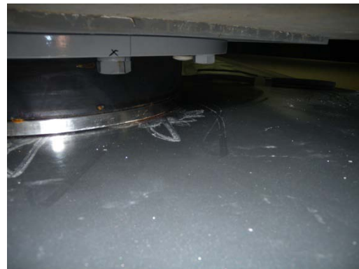
写真 5. 5. 1-23 すべり面に生じたたきず
