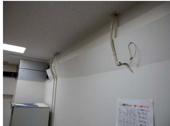
写真 5.5.1-4 B 1 階 E V 入口天井部での衝突痕 写真 5.5.1-5 免震スリット位置での内装の折れ
