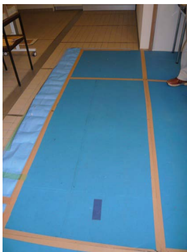
写真 5. 5. 1-49 1階エレベーター周囲の養生 (補修後)
