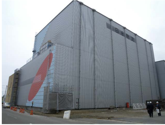
図5.5.1-7 B建築物（鉄骨造）
