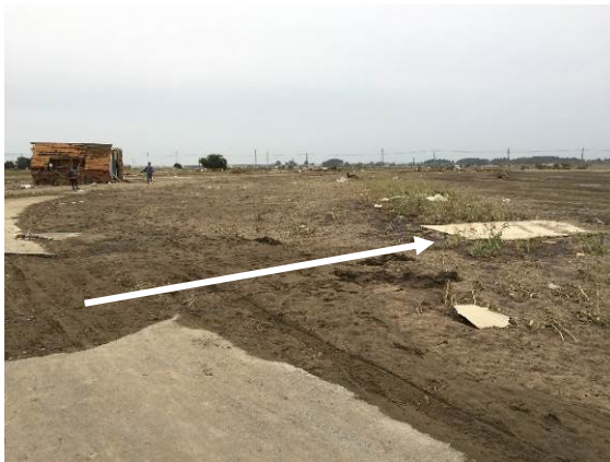
写真 4 1 コンクリート路盤の流出 (矢印は流出の方向)
