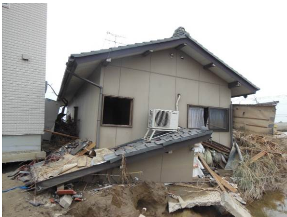
写真 2 6 住宅 A とプレハブ住宅の衝突状況
