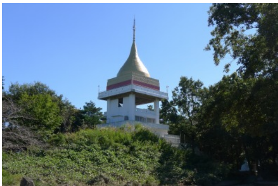
写真48 鉄筋コンクリート造の慰霊塔
