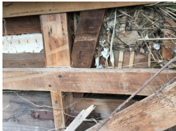
写真5 住宅Bの筋かいと土塗壁
