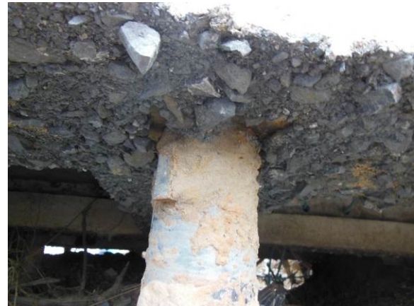
写真 2 9 杭と基礎底面に付いた割栗石
