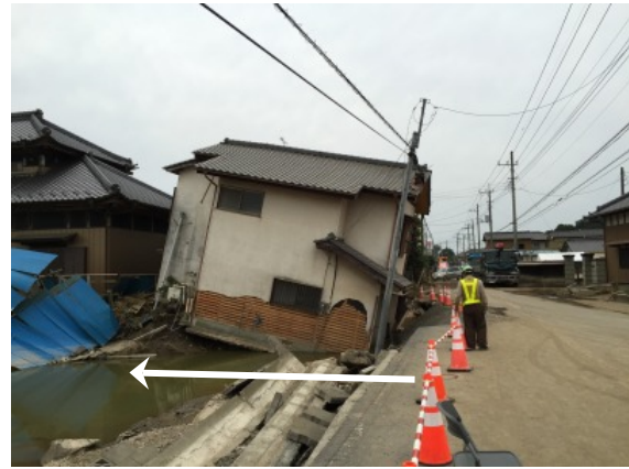
写真17 住宅Hの傾斜 (矢印は水流の方向)
