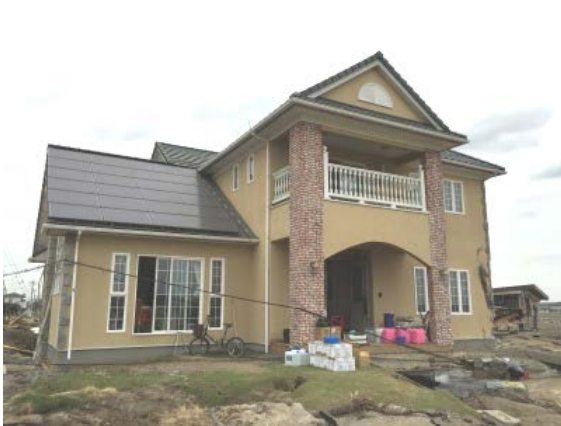
写真12 住宅Fの外観
