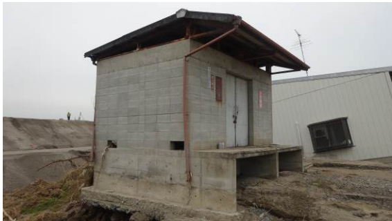
写真36 コンクリートブロック造倉庫
