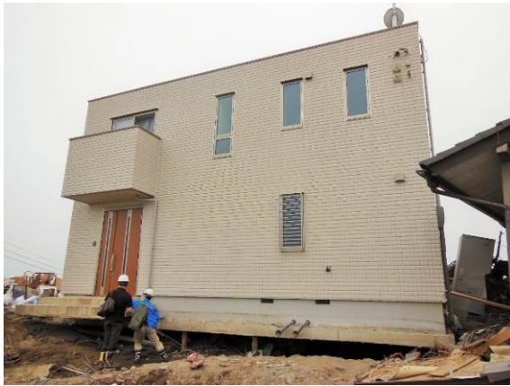
写真 2 4 プレハブ住宅の外観
