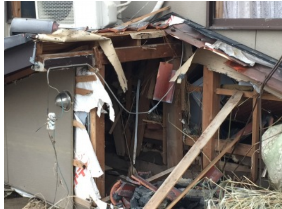
写真3 住宅Aの構造躯体
