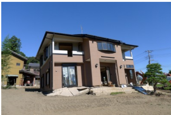
写真 4 6 傾斜した住宅 K
