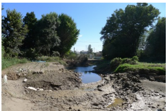
写真51 住宅Kの近隣での地盤の洗掘
