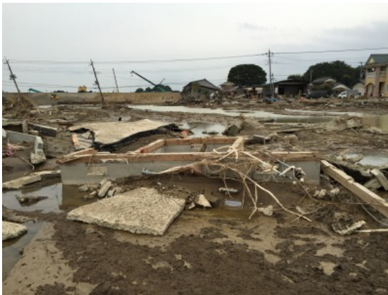
写真10 住宅Eの基礎の一部
