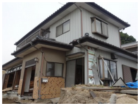
写真21 住宅Jの外観
