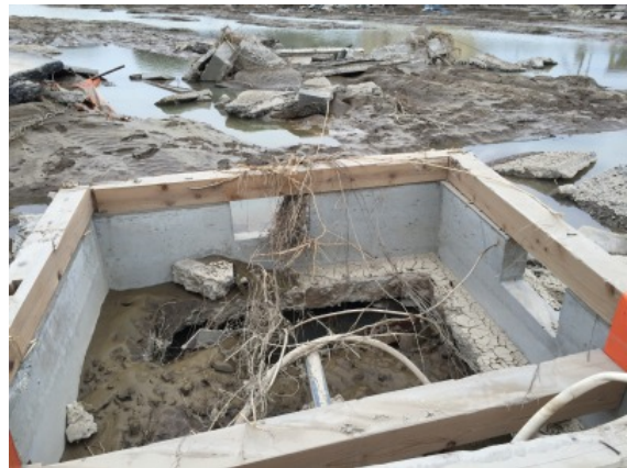
写真11 住宅Eの基礎と土台
