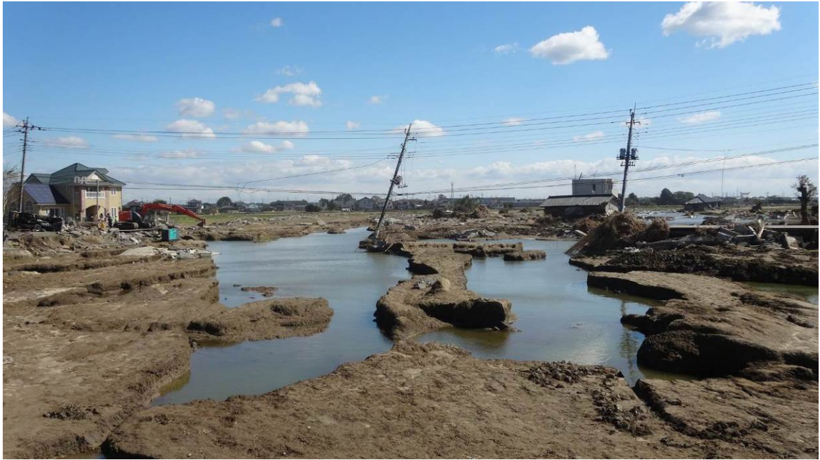
写真 4 5 地盤の侵食状況
