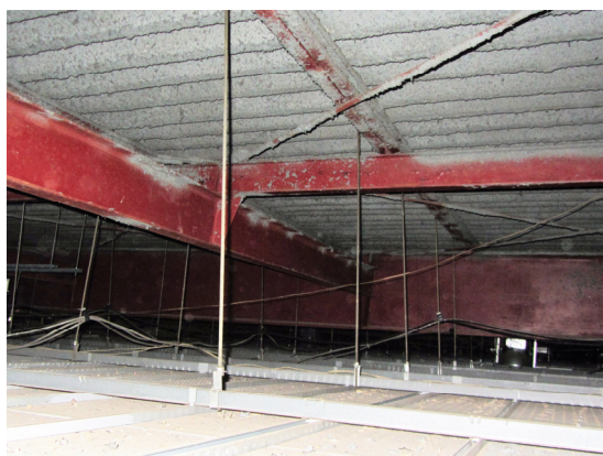
写真4-24 天井裏の状況
