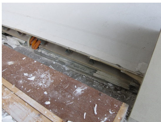
写真 4-65 間仕切り壁の下部の留め付け箇所の状況 (3階)
