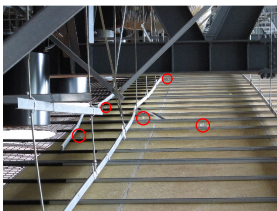
写真 4-9 野縁受けの曲がりやクリップの外れ（赤円内。メインアリーナ）
