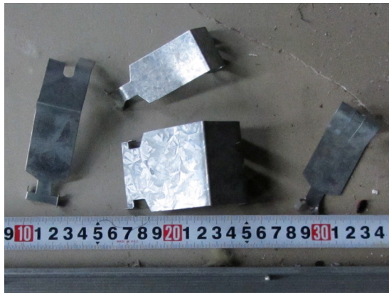
写真4-74 落下したクリップ
