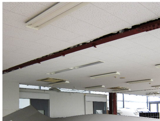
写真 4-64 間仕切り壁の上部の留め付け箇所の状況 (3階)
