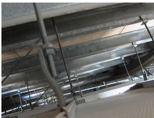
写真4-46 天井裏（サブプール）
