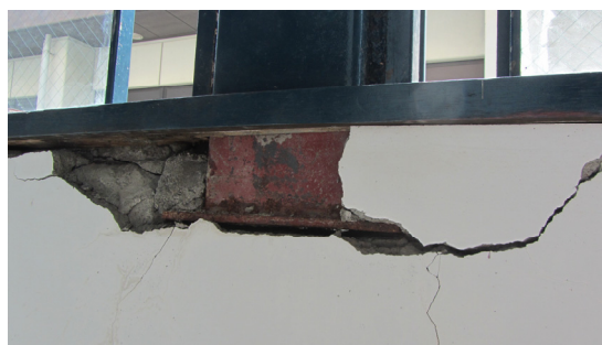
写真 4-90 前写真の支承部から観覧席に落下したコンクリート (3階観覧席) 写真 4-91 桁行構面の柱脚 (3階観覧席)
