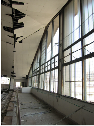
写真 4-84 開口部の被害 (3 階観覧席)
