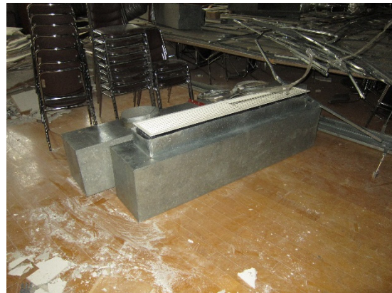
写真4-75 設備の脱落
