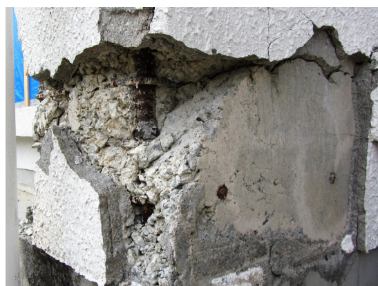
写真 4-55 柱脚の損傷
