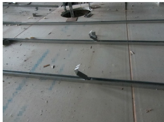
写真4-73 クリップのツメの開き
