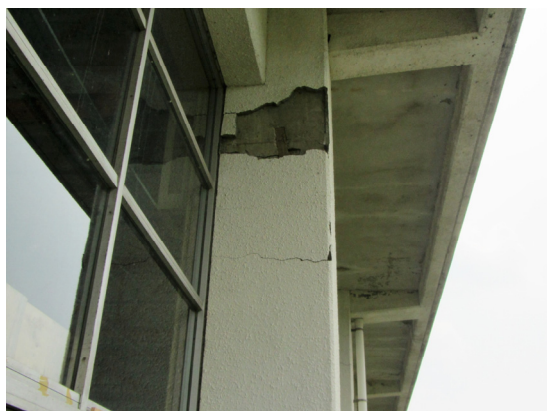
写真 4-56 柱頭の損傷
