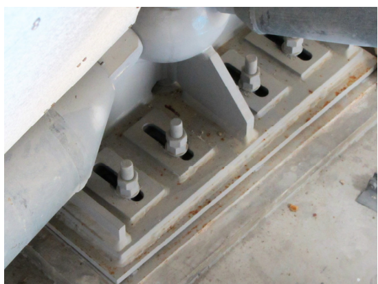
写真4-45 屋根支承部（サブプール）
