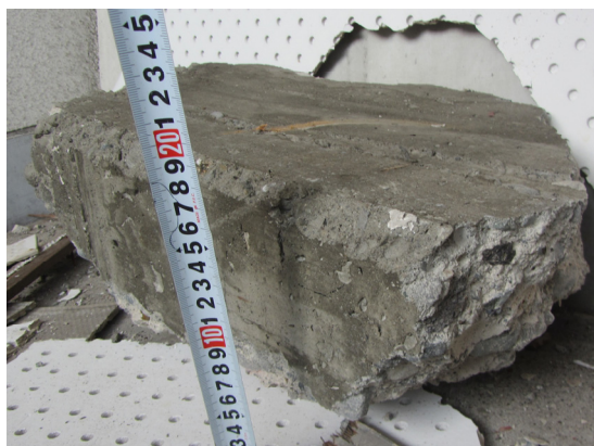
写真 4-90 前写真の支承部から観覧席に落下したコンクリート (3階観覧席) 写真 4-91 桁行構面の柱脚 (3階観覧席)
