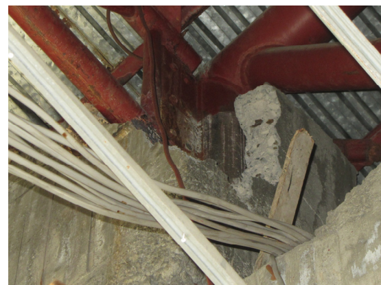
写真 4-89 舞台際の支承部
