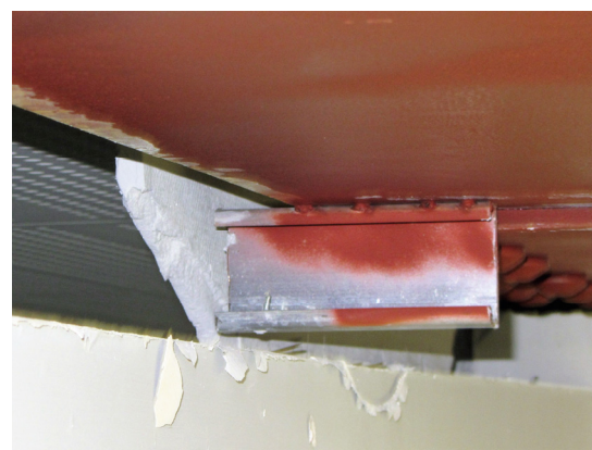
写真 4-66 間仕切り壁上部を取り付けるためのC形鋼ピース (2階)
