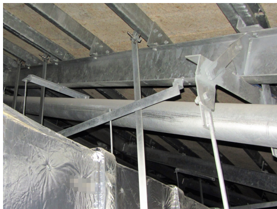
写真4-41 天井裏の吊元の様子（メインプール）
