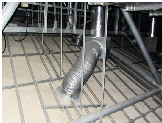
写真4-40 天井裏（メインプール）
