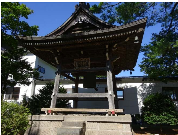
写真 5.3.35 鐘楼の脚部の補強
