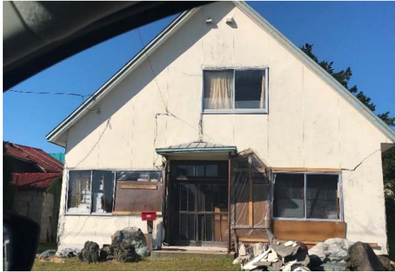
写真 5.3.37 外壁の剥落
