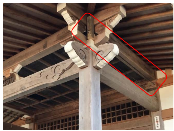
写真 5.3.34 写真 5.3.33 の補強部分
