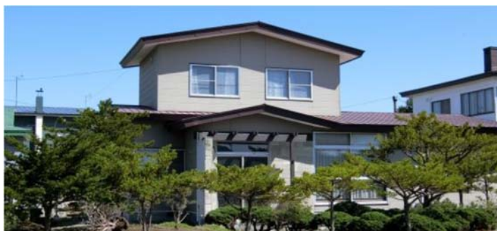
写真 5.1.16 地震計付近ではほぼ無被害のように見受けられる専用住宅
