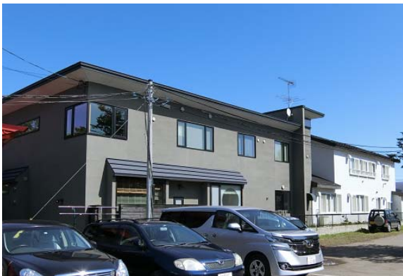
写真 5.2.18 外観上無被害に見受けられる住宅
