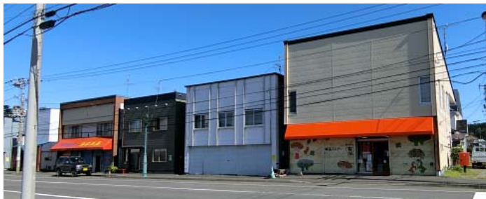
写真 5.3.25 店舗併用住宅が建ち並ぶ通り
