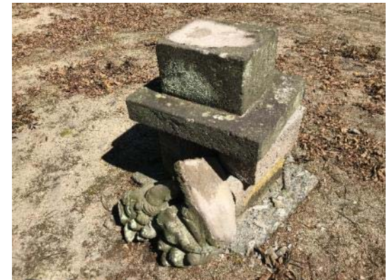
写真 5.2.14 寺社建築 C 付近の工作物の破壊状況
