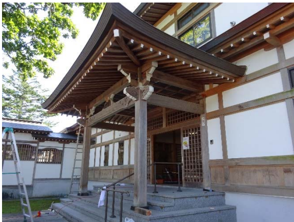
写真 5.3.33 社寺建築の玄関部分の補強
