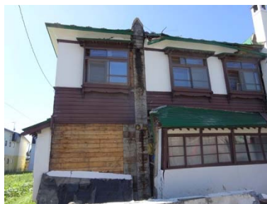
(b) 煙突の倒壊
