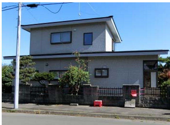
写真 5.3.28 無被害に見受けられる外壁がサイディングの比較的新しい住宅
