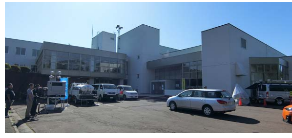
写真 5.3.4 無被害に見える早来町民センター庁舎
