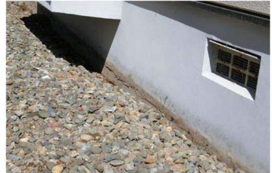
(b) 地中部分の一部が露出した基礎
