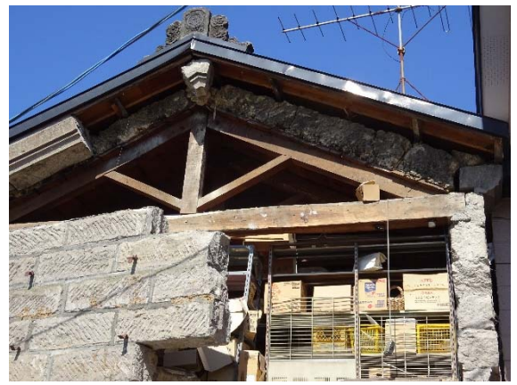
写真 5.3.18 写真 5.3.17 の小屋組
