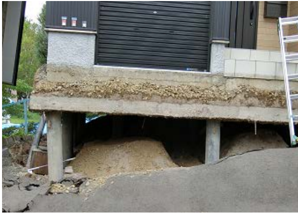
写真 5.19 杭（円形）状地盤補強を講じたと思われる住宅の基礎
