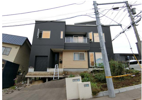
写真 5.20 周囲より建築物全体の傾斜が小さい 写真 5.19 の住宅
