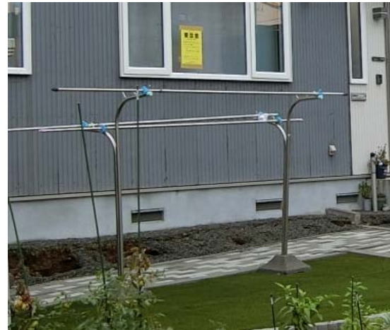
写真 5.16 地盤が沈下しているにもかかわらず、ほぼ無被害に見える基礎
