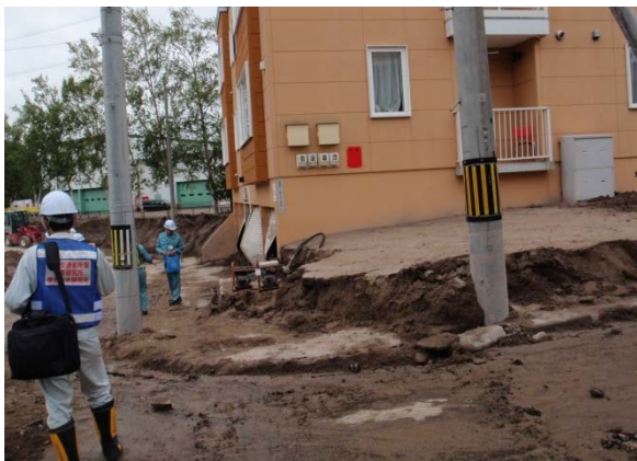
写真 5.28 流出した土砂の堆積状況
