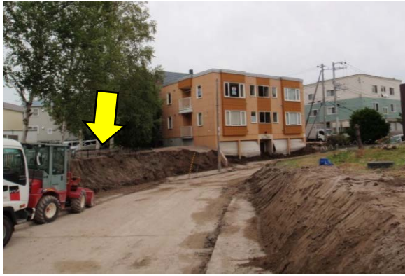
写真 5.30 流出土砂撤去後（矢印は運送会社事業所の敷地）
