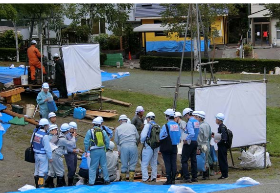
写真 5.11 ボーリング作業と調査団
