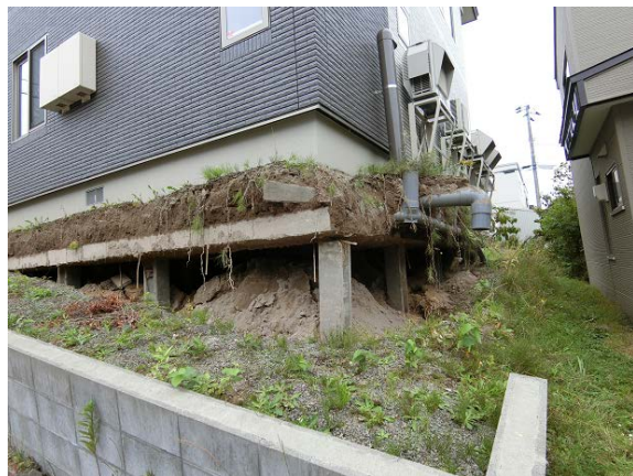
写真 5.18 杭（角形）状地盤補強を講じたと思われる住宅の基礎
