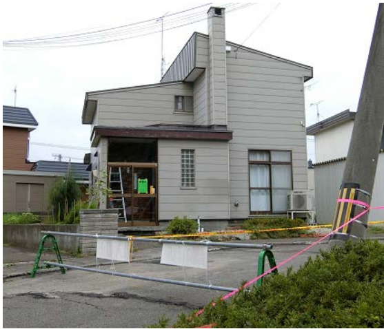
写真 5.15 写真 5.3 の住宅の 2 軒南側でほぼ無被害の住宅
