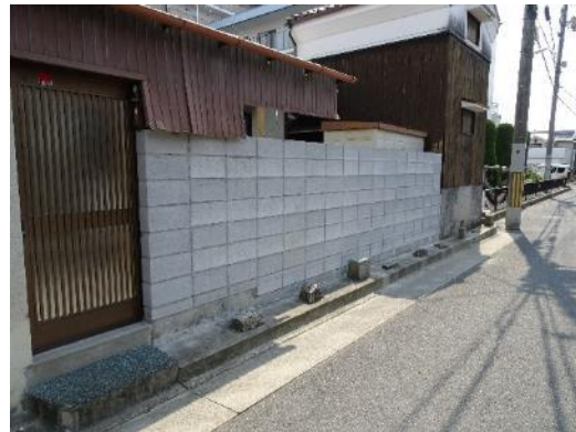
(b) 全景 2 (被災後・修復された塀)
