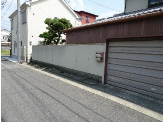
(a) 全景 1 (被災後)
