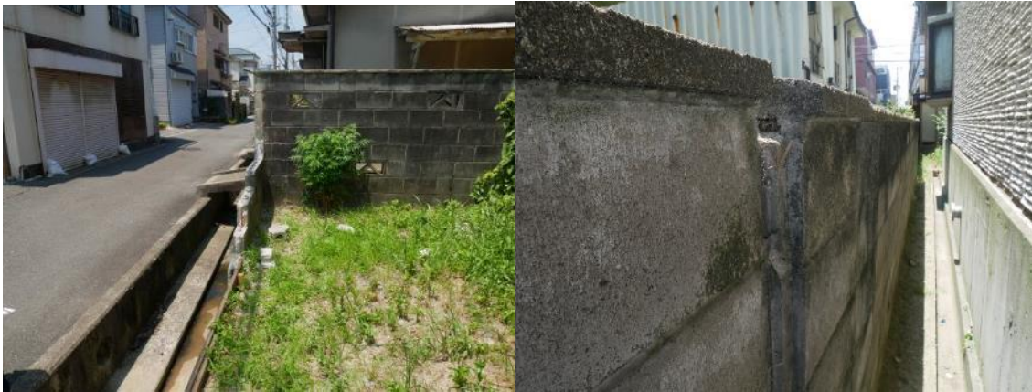
(a)東西方向の補強ブロック塀
