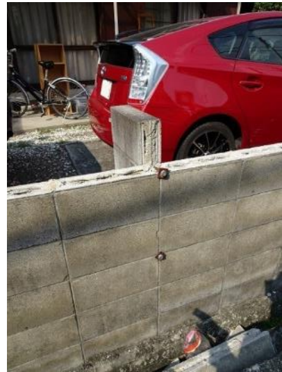
(b) ボルトで緊結された控え壁
