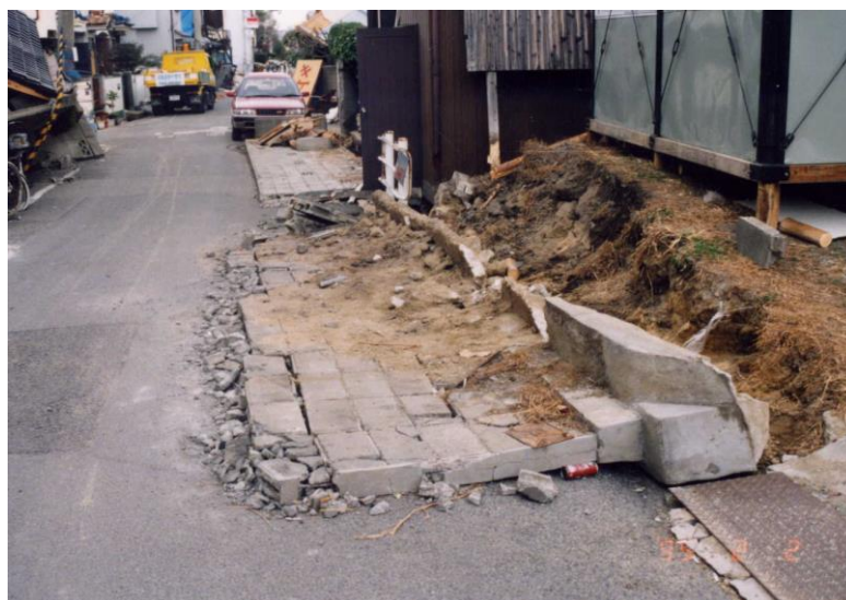
図 7.25 根入れ深さの浅い RC 造基礎ごと転倒した例 8) (大分大学・菊池教授提供)
