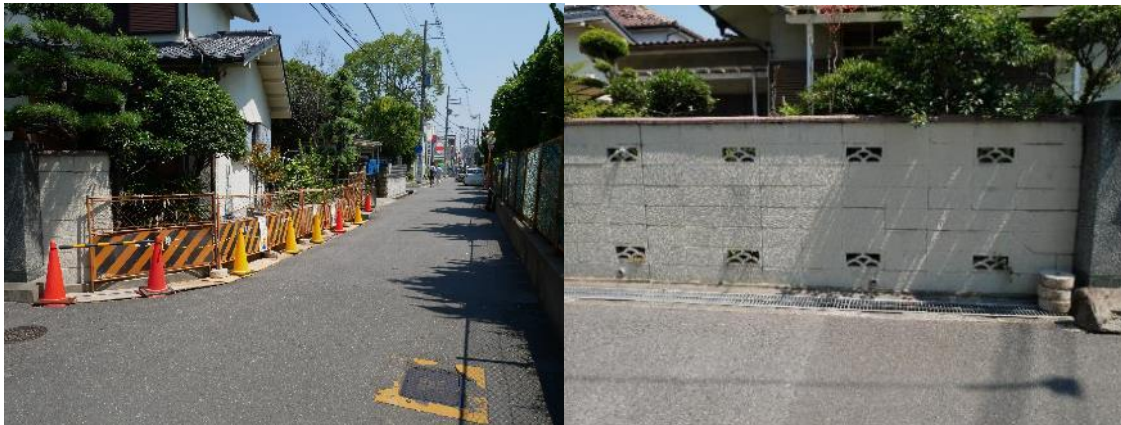
(a) 南北方向の補強ブロック塀
