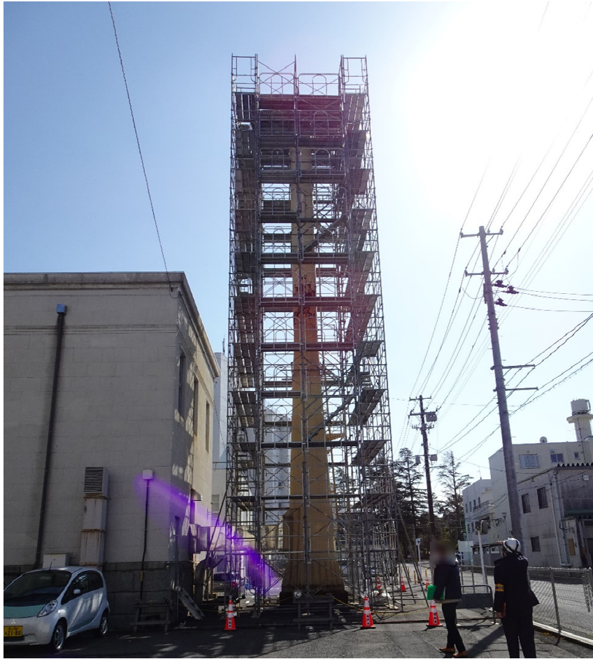
図 4.2.2 鋼製煙突 B 外観
