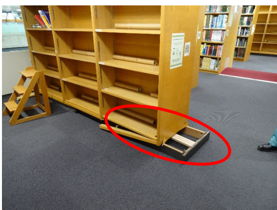
(c) 本棚の被害 (赤丸部)
