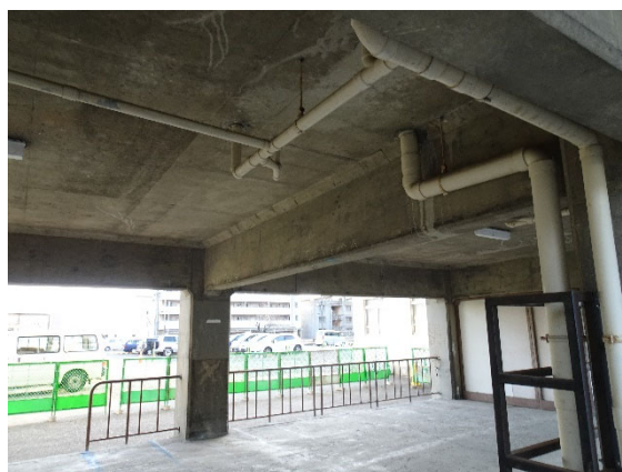
(b) ピロティ構面の梁
