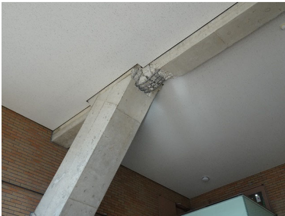
(a) 3 階梁の破壊
