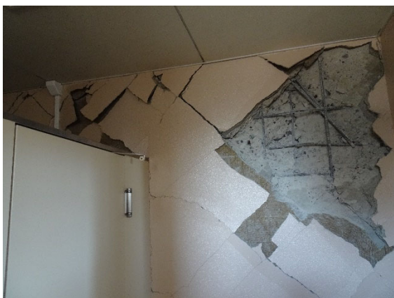
(a) 南側妻構面耐力壁
