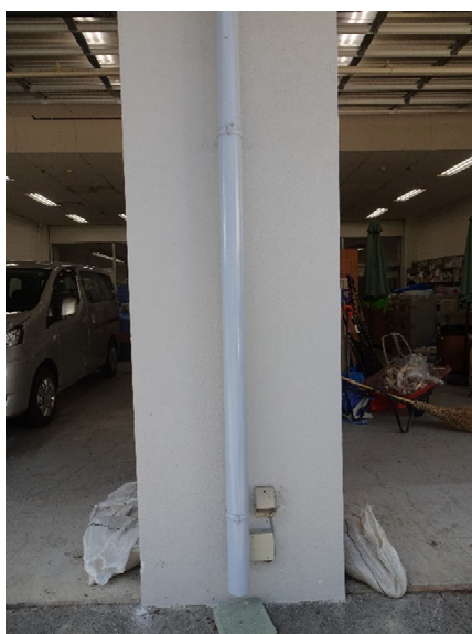
(a) 地下 1 階補強柱
