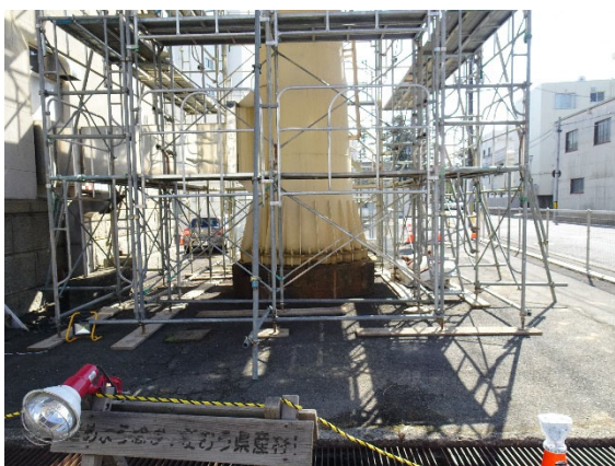
(c) 鋼製煙突の下部
