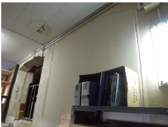
(a) 建築物 3 階増打ち壁
