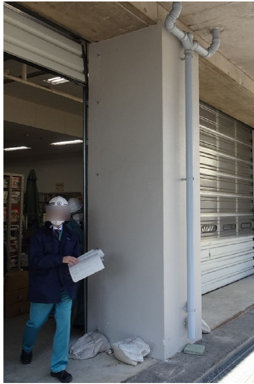
図 4.1.2 シート巻き付け補強された地下階の柱
