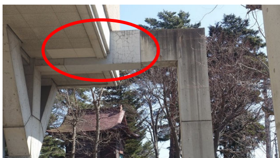
(c) 南側室外の炭素繊維補強 (赤丸部分) された梁
