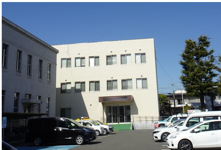
図 4.2.3 建築物 B に隣接する建築物の外観
