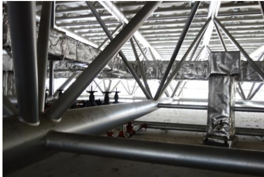
写真5-3 トラス屋根 (下側が音楽ホール屋根)
