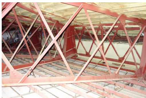
写真5-21 鉄筋コンクリート造柱と鉄骨造屋根の接合部の状況
