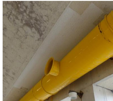
写真 5-26 復旧の形跡を確認した天井部分
