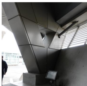
写真5-45 鉄骨柱部材
