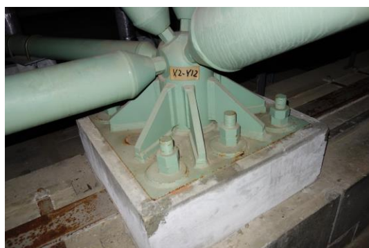
写真5-51 鉄筋コンクリート造柱と鉄骨造屋根の接合部の状況
