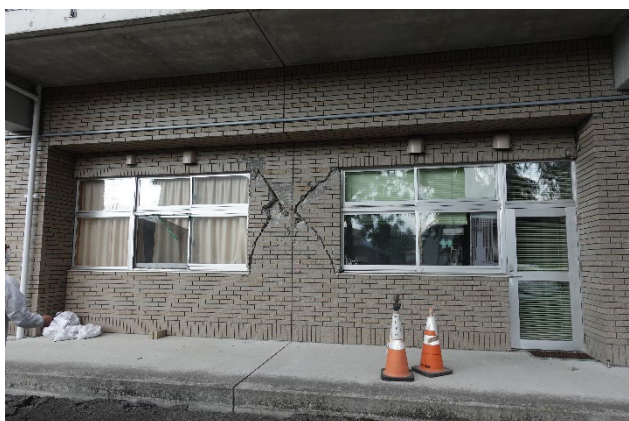
図 4.1.2 (c) 非構造壁のせん断破壊
