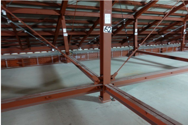
(a) 柱の様子
