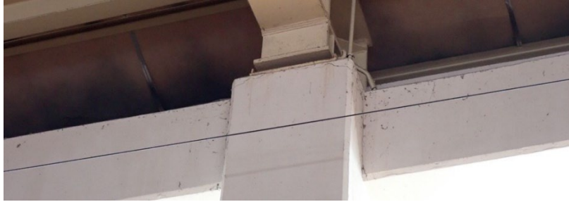
(a) 2 階柱頭の置き屋根支承部
