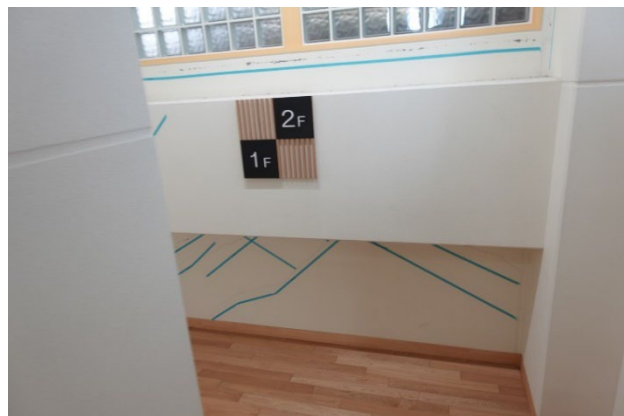
(b) 階段室壁 (北面)
