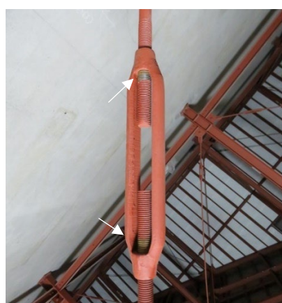
(b) ターンバックルの増し締め
