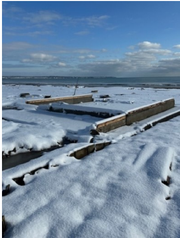
図 6.2.3 建築物の流失(1)
