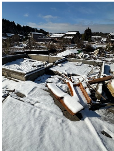
図 6.3.1 流失した住宅(1)
