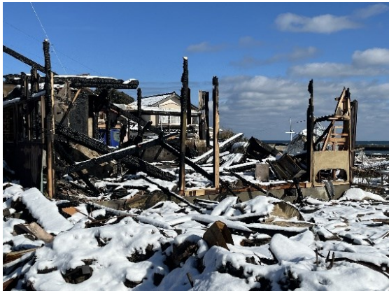
図 6.3.15 火災被害状況(1)
