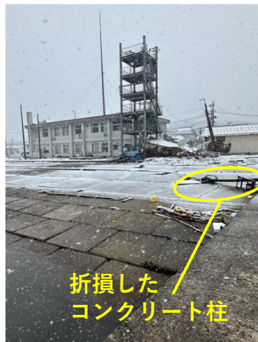
図 5.3.7 海からの被害状況
