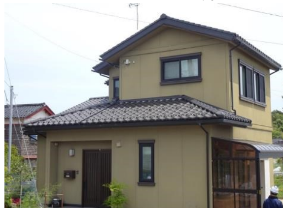
図 5.4.5 令和 5 年 5 月の地震後の状況 (J 形瓦) 6)
