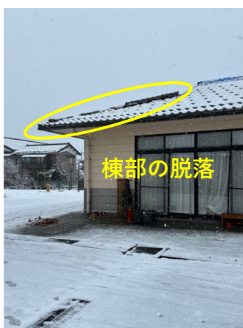
図 5.4.2 棟部の被害
