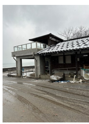
図 5.5.6 RC 造の建築物の被害状況(2)
