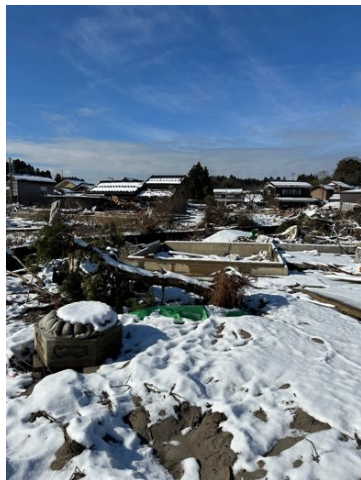
図 6.3.2 流失した住宅(2)
