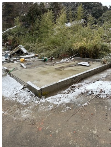
図 5.5.1 流失した建築物
