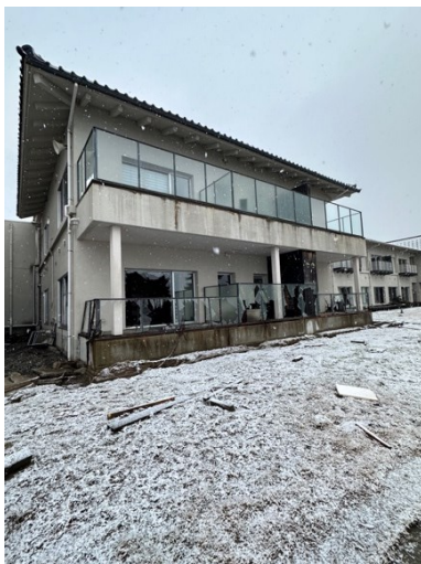
図 5.1.1 建築物の外観
