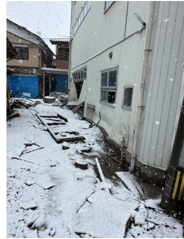
図 5.3.3 外壁の損傷
