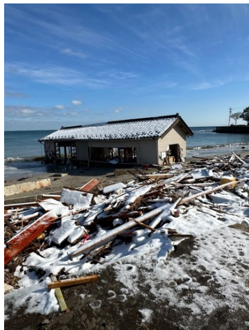
図 6.3.8 住宅の2階部分の移動
