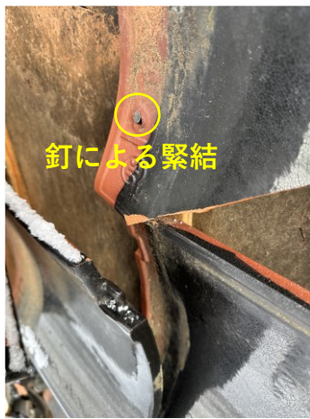
図 6.2.18 瓦の緊結状況
