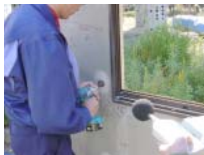
改修工事における騒音の測定
