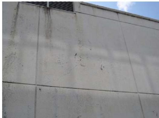
写真1 劣化した仕上げ塗材の例
