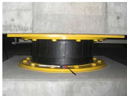
写真2 免震装置(地階に設置)
