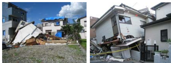
図4 木造住家の上部構造の倒壊
