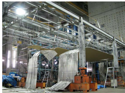
写真4 クリップの外れによる天井面の落下
