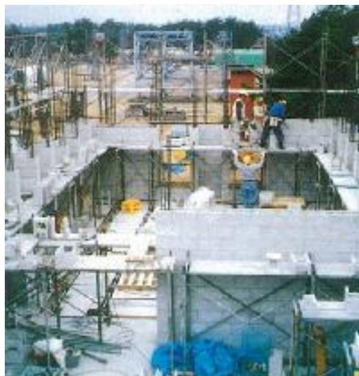
RM打込み目地構法による実施工実験風景
