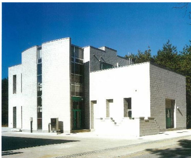
構工法実験棟外観
