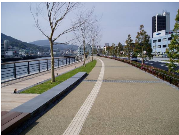
写真 2 美しく仕上がった長崎市浦上側沿いの歩道
