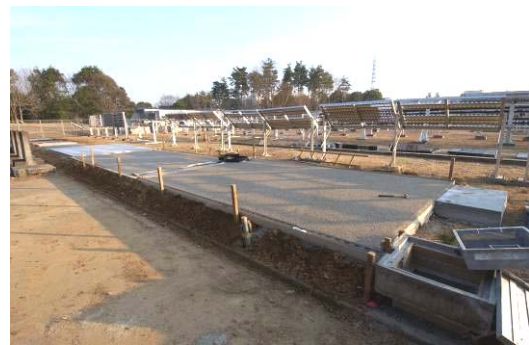
写真 3 「涼感舗装」の実証実験装置
