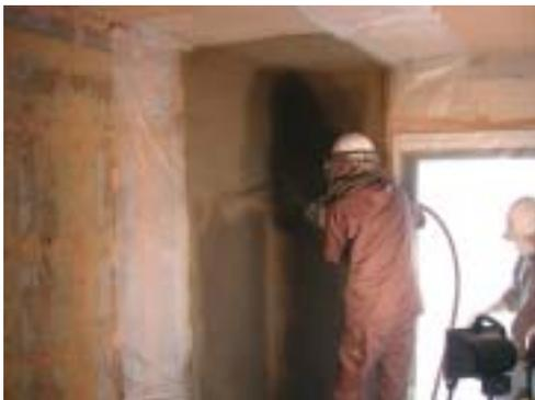
写真 2 施工時の状況（湿式工法）
