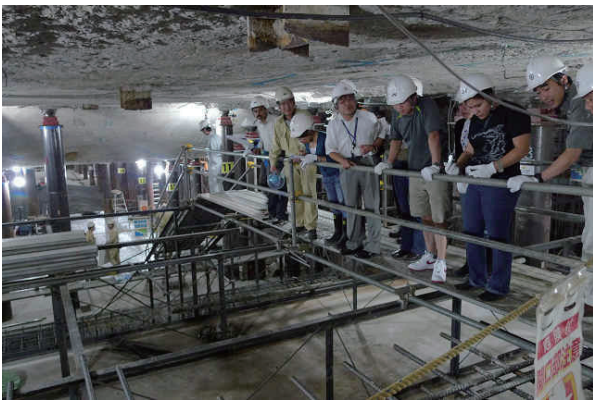
写真7 耐震改修（免震化）工事現場の視察（2009年：つくば）
