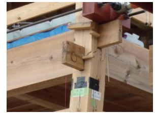
写真8 試験体A棟の柱折損
