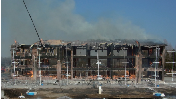
写真6 倒壊直前(65分後)
