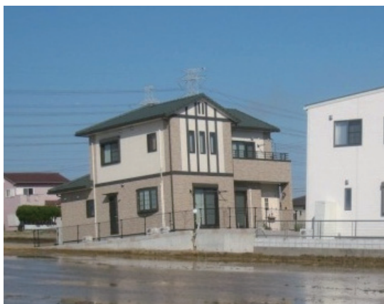
図4 液状化による傾斜
