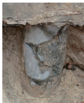
図11 杭の被害
