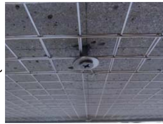
メッシュとアンカーの緊結状況
