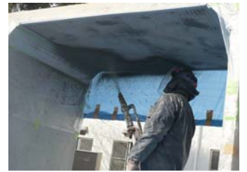
上面への吹付け施工状況
