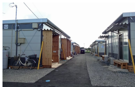
図 17 プレハブ建物の住棟間隔（熊本県益城町）
