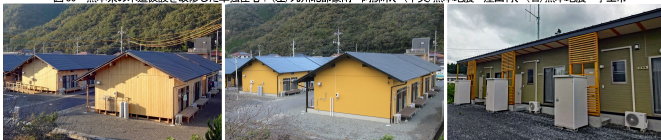
図31 岡山県総社市の木造仮設の改修事例：(左)改修前の仮設住宅、(右)改修後の単独住宅
