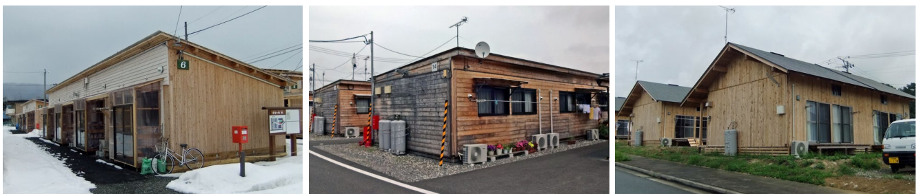
図9 東日本大震災における木造仮設住宅：(左)岩手県遠野市 (中央)宮城県山元町 (右)福島県いわき市
