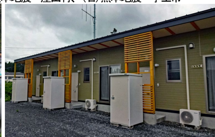
図32 定住促進住宅(宮城県南三陸町)
