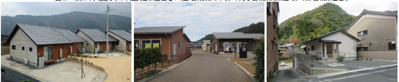
図27 熊本地震・西日本豪雨での木造災害公営住宅：(左)熊本県南阿蘇村、(中央)熊本県甲佐町、(右)愛媛県大洲市
