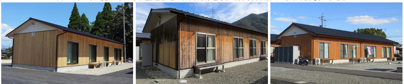
図10 “熊本型”の木造仮設住宅：(左)熊本地震・熊本県阿蘇市 (中央)西日本豪雨・愛媛県大洲市 (右)令和2年7月豪雨・熊本県人吉市
