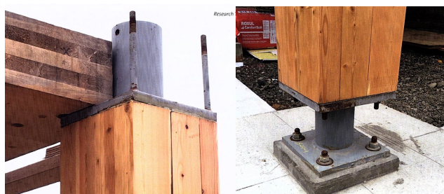
写真5 カナダの18階建て学生寮における柱の鉛直接合部
