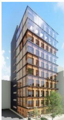
図5 11階建て木造(免震構造)
