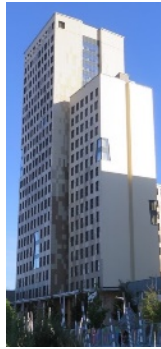
写真2 24階建て複合ビル(オーストラリア)
