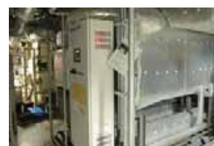
写真：改修した熱源機器
