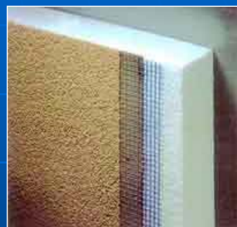
外壁外断熱イメージ図
