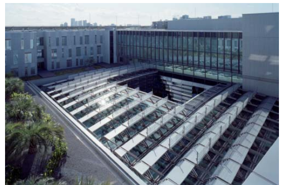
インナーボイド頂部のルーバー (自然光の導入と日射遮蔽)
