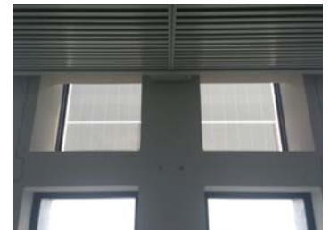
薄膜型パネル (執務室窓等に設置)
