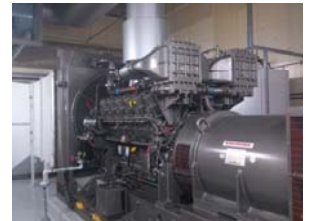
屋上発電機室
