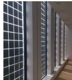
多結晶型パネル (共用部窓に設置)
