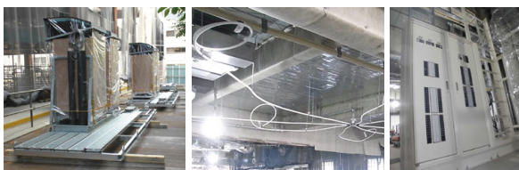
【空調】室外機ユニット 【衛生】SP配管ユニット 【電気】ESユニット 労務削減と同時に廃棄物削減を通じて施工段階でのCO 2 を低減
