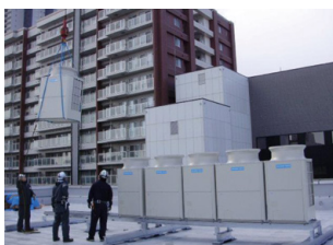
ヒートポンプ室外機搬入
