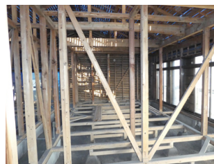
耐震改修により構造強度をアップ
