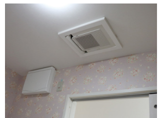
浴室を高断熱化し、専用暖房を取り付け
