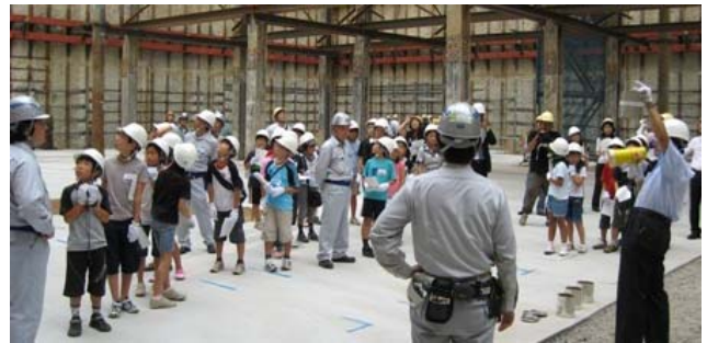
施工中のエコ見学会
