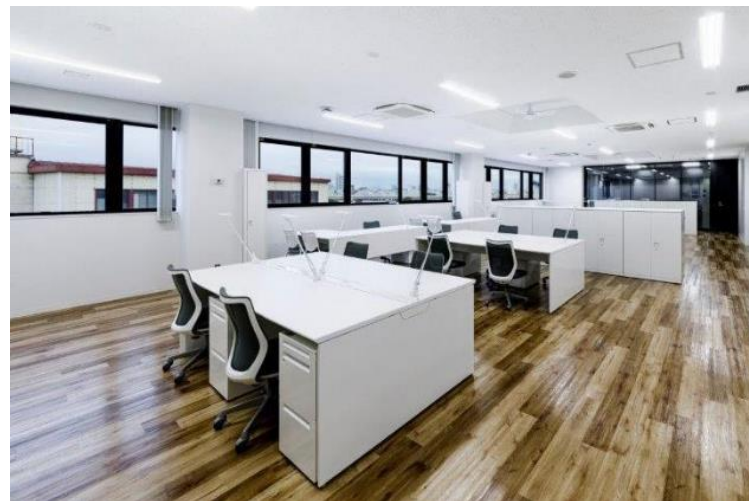
▲4階事務室：ベース照明は明るさを検知して照度を自動調整している。
