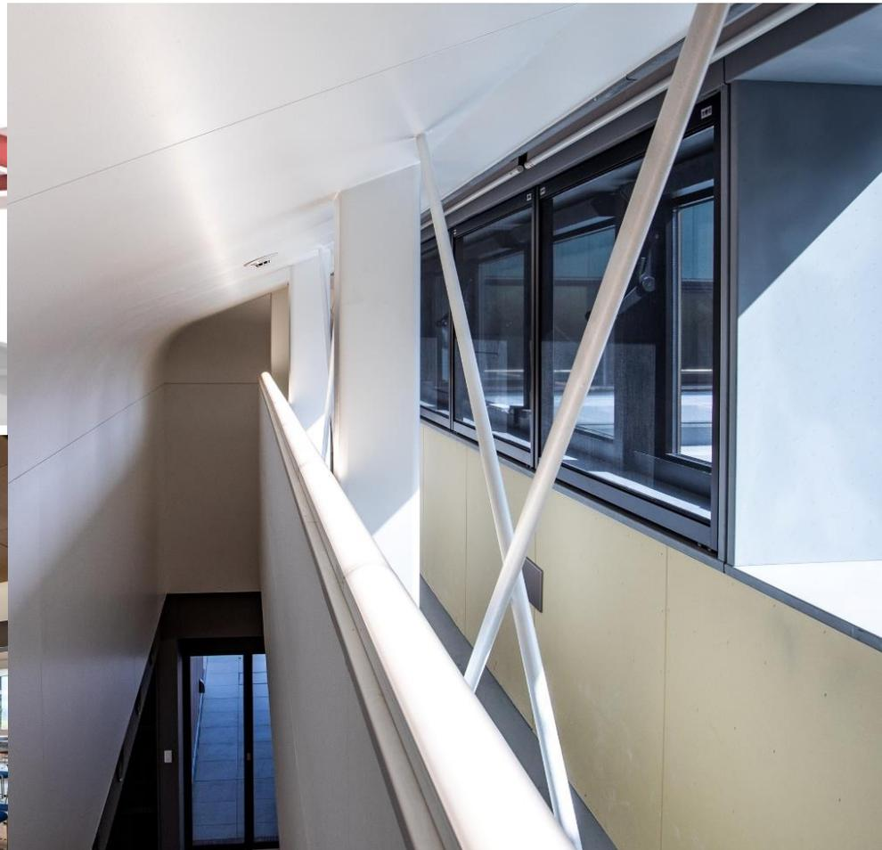
中央のホールの天井を吊るように構成しスウィンドウによる自然換気・自然採光を確保している。ホールを見上げると天井が浮いたように存在し、晴天日は採光確保による照明エネルギーの削減、空調換気エネルギーの削減に寄与している。
