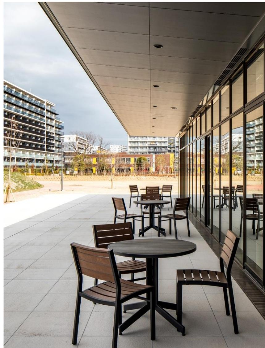
深い庇により日射を抑制し、冷房負荷の削減・省エネを実現している。
