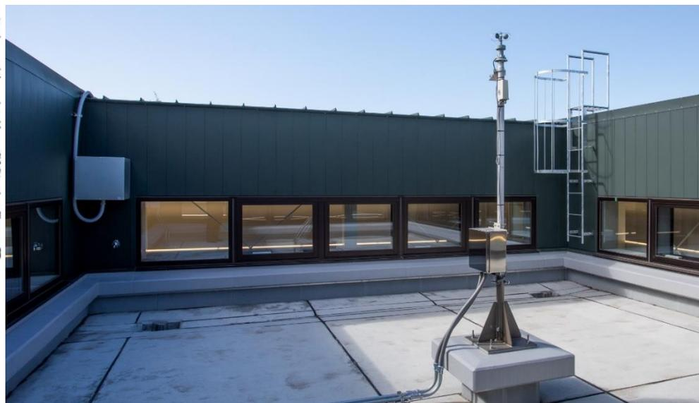
西風以外は比較的存在的な地域性・特に北風が主風向であるため、北側に外気取り入れ口を多く配置している。排気側のスウィンドウは屋上4面に配置することで風向きが何であっても頂部に負圧帯を形成できる仕組みとし、安定的に自然換気を促す建築計画としている。
