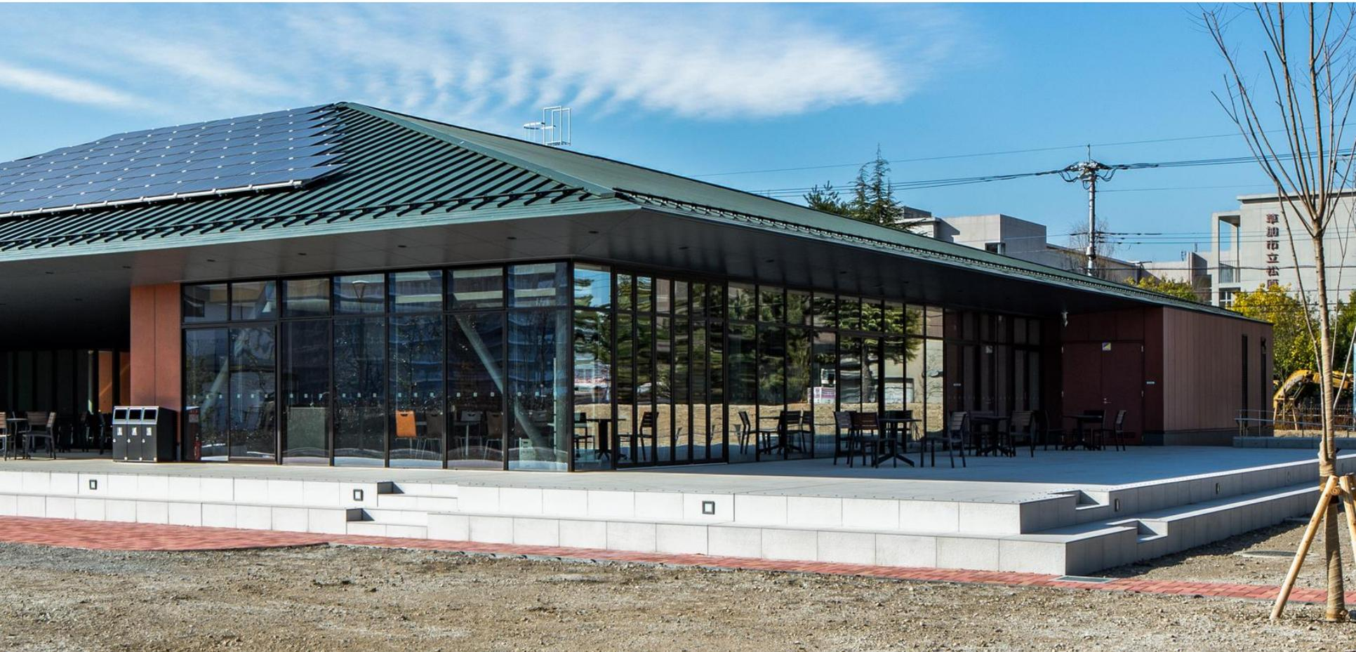
開口部のガラスには高断熱の真空ガラス（スーパー Spaceria：熱貫流率 $0.65\text{W}/\text{m}^2 \cdot \text{K}$ ）を採用。
