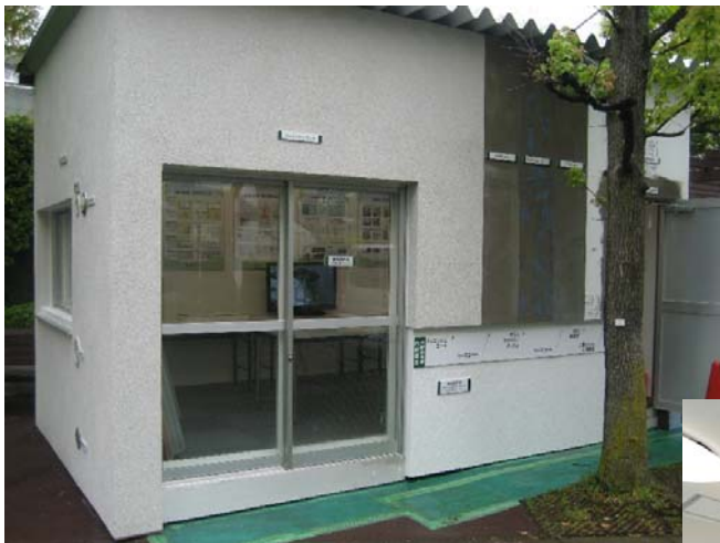
▲サンプルルームの外壁に実際の外断熱仕上行程を再現。サッシには樹脂内窓を取り付けた
