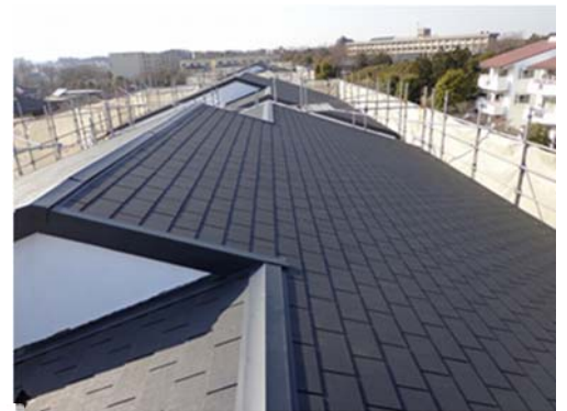
↓ スレート瓦葺き完了
