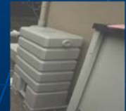
雨水タンク設置
