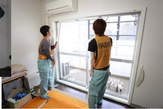
樹脂サッシ取付け
