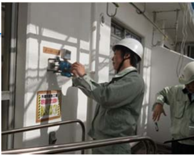
← 外壁塗装引張り試験
