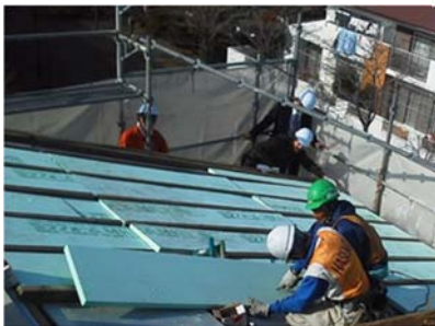
↓ 新規断熱材敷き
