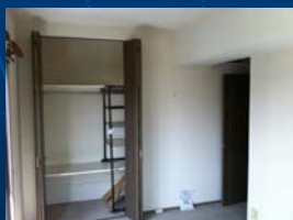
寝室の通風を確保するために壁を開口、建具を設置
