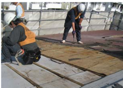
↓ 既存屋根撤去
