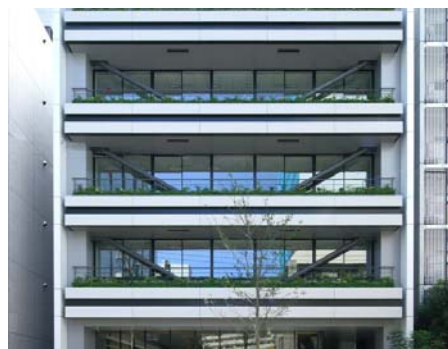
ファサードに表した付加制振ブレース
