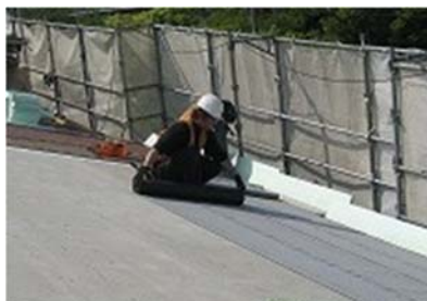
↓ 防水シート敷き
