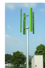
小型風力発電設備
