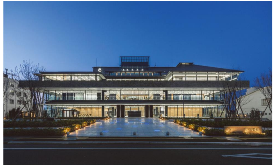
外構LED照明
