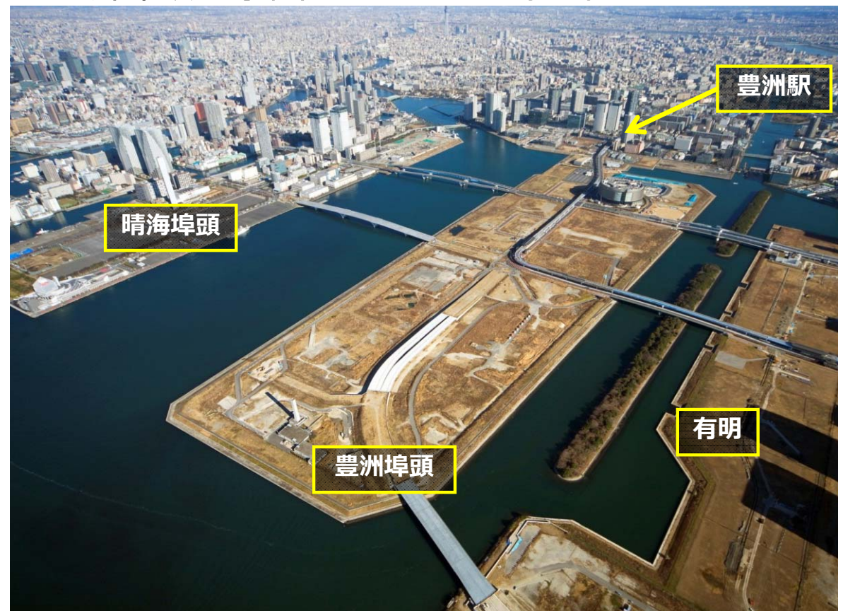
豊洲埠頭全景図 (2010年11月撮影)
