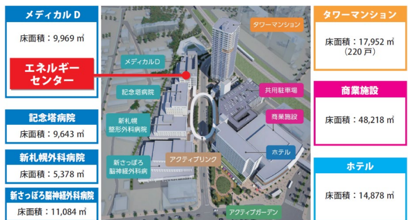
図1 新さっぽろI街区全景
