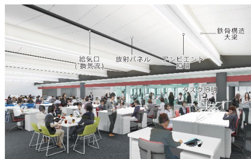
放射空調・アンビエント照明・構造計画の統合のイメージ
