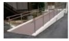
スロープの設置
