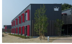
CLT工法による木造ホテル
